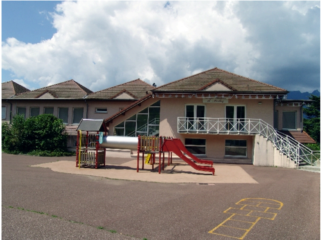
Façade est, détail
