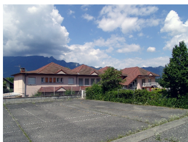
Vue prise du sud-est Phot. François Fouger IVR82_20097301035NUCA
