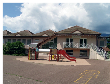
Façade est, détail Phot. François Fouger IVR82_20097301036NUCA
