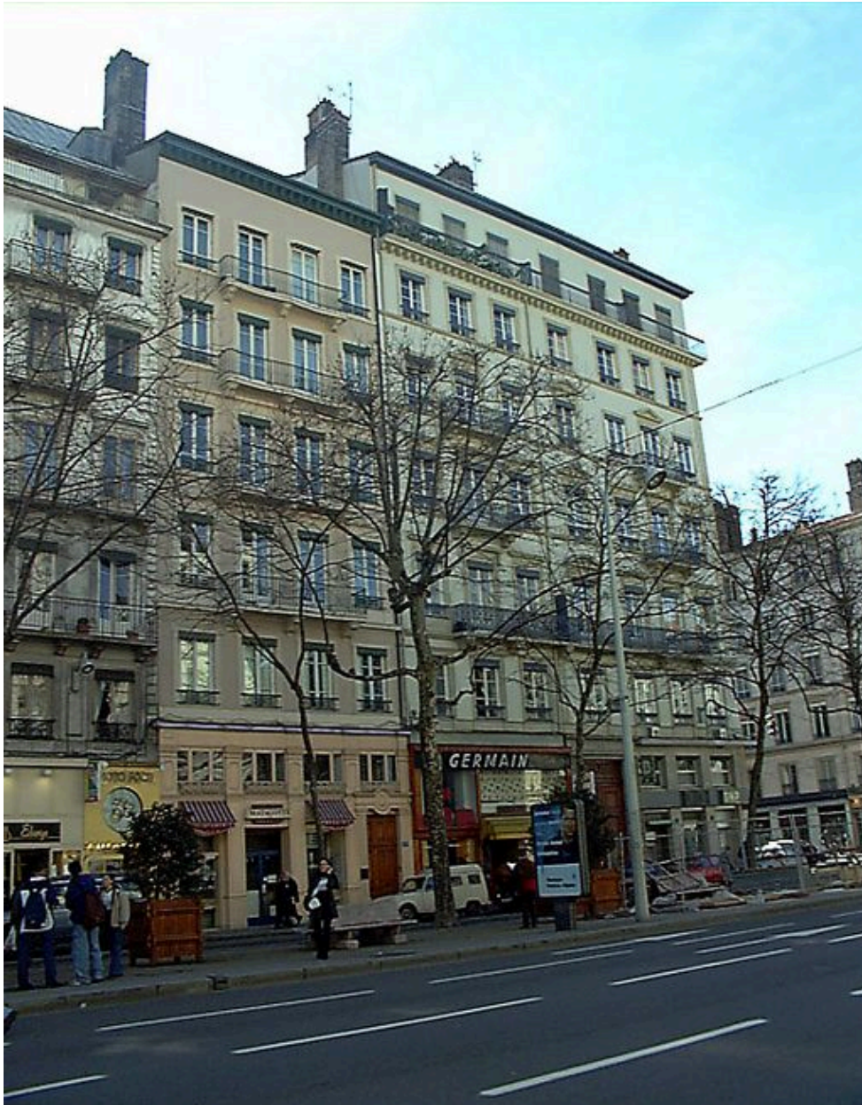
Façade sur rue, vue générale
