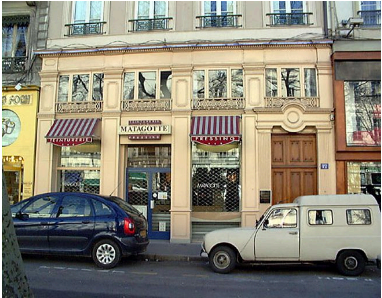
Façade sur rue, détail du rez-de-chaussée et de l'entresol
