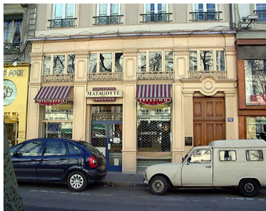
Façade sur rue, détail du rez- de-chaussée et de l'entresol Phot. Bernard Ducouret IVR82_20016900837NUCA
