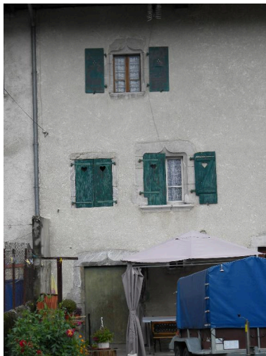
Détails d'encadrement sur la façade principale. Phot. Jérôme Daviet IVR82_20137400918NUCA
