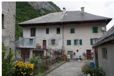
Vue de la façade principale depuis la route de Viuz Phot. Emmanuel Breteau IVR82_20137400826NUCA
