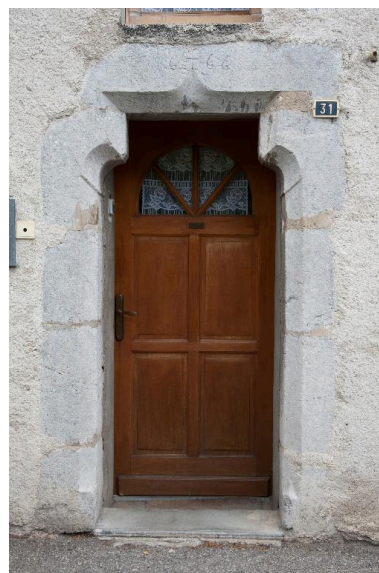
Vue d'un encadrement chanfreiné avec piédroits à congés et linteau en accolade sur coussinets Phot. Emmanuel Breteau IVR82_20137400827NUCA
