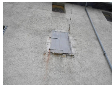
Vue d'une fenêtre à accolade en façade nord. Phot. Jérôme Daviet IVR82_20137400923NUCA
