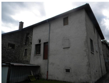
Vue des façades nord et ouest Phot. Jérôme Daviet IVR82_20137400922NUCA
