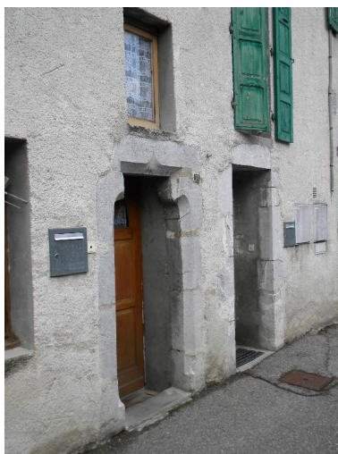
Vue d'encadrements de portes sur la façade est. Phot. Jérôme Daviet IVR82_20137400921NUCA
