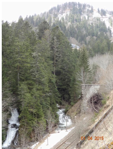
L'entrée du tunnel côté Laveissière, avec la date portée 1868 (photo chercheur). La date de 1865 se trouve à l'extrémité sud (commune de Saint-Jacques-des-Blats). Phot. Bénédicte Renaud-Morand IVR83_20151500064NUCA
