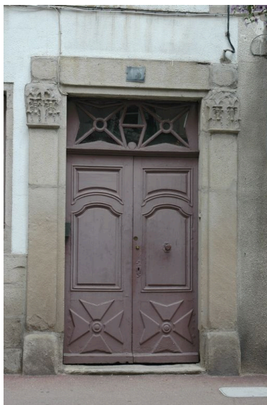
Porte d'entrée : pilastres à chapiteaux corinthiens en remploi. Phot. Simone Hartmann-Nussbaum IVR82_20124201343NUCA
