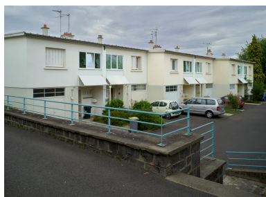
Ensemble de pavillons doubles accolés avec décrochement, de type "Bezance", dans la partie basse de l'îlot 1.
