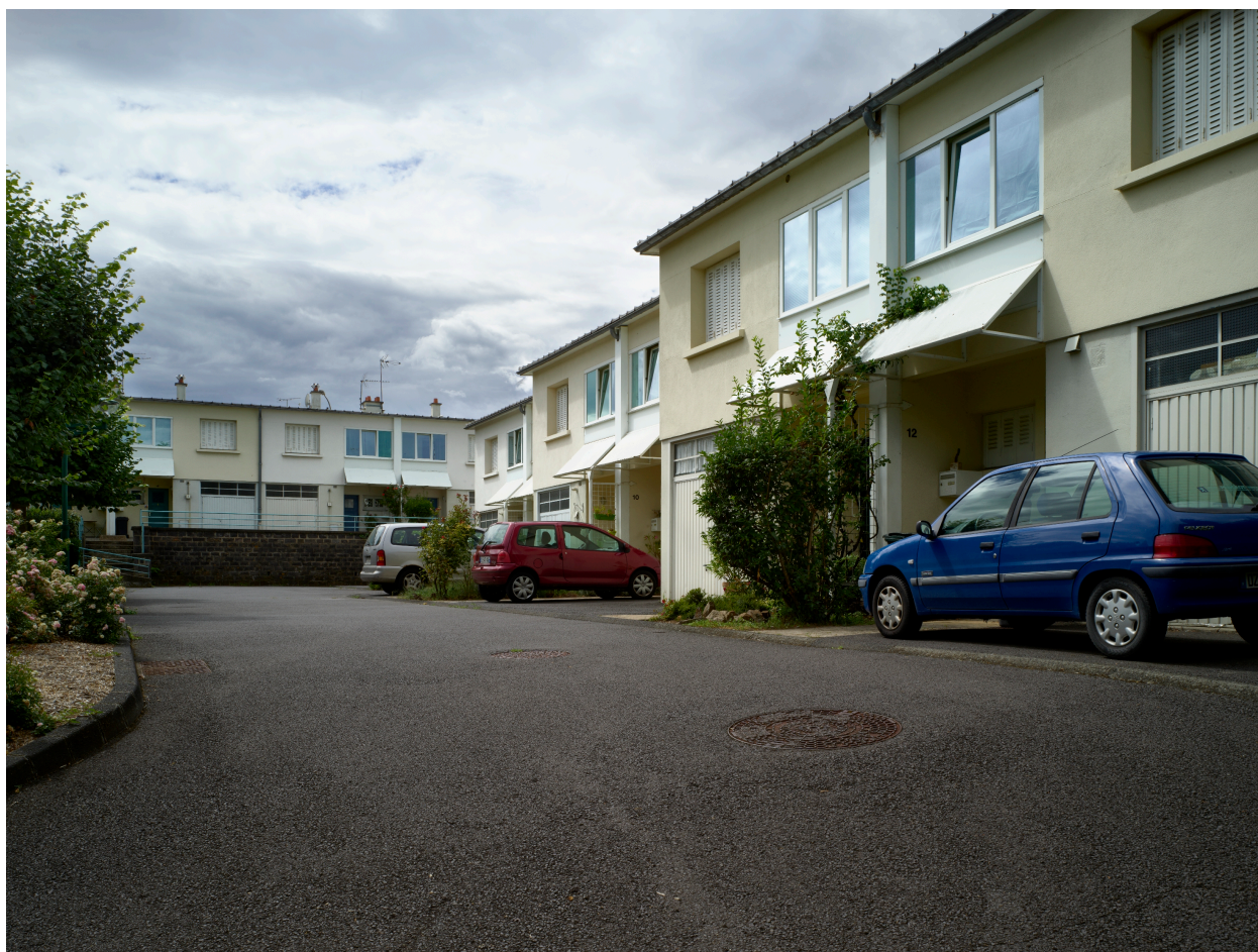
Ensemble de logements doubles accolés avec décrochements ou en bande, de type "Bezance", dans l'îlot n° 1.
