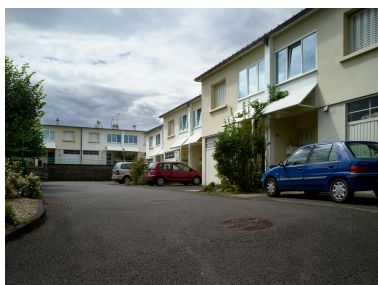
Ensemble de logements doubles accolés avec décrochements ou en bande, de type "Bezance", dans l'îlot n° 1.
