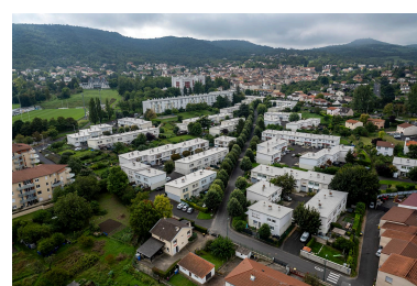
Vue aérienne de la cité depuis le nord. Phot. Michel Pérès IVR84_20246302208NUCA
