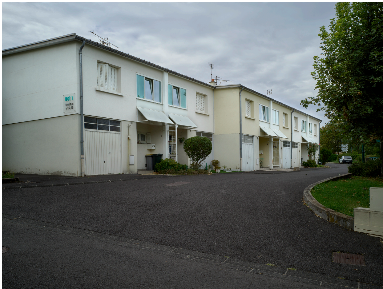
Ensemble de pavillons doubles accolés avec décrochement, de type "Bezance", dans la partie haute de l'îlot 1.
