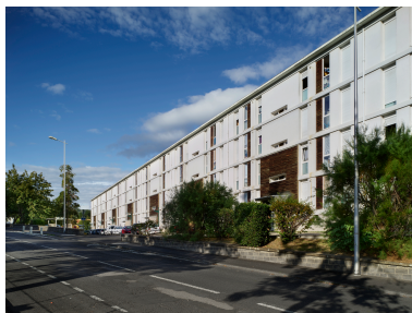
Le plus grand des deux immeubles collectifs du sud-est de la cité, depuis l'avenue Jean-Moulin.
