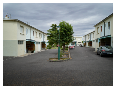
Petite place intérieure de l'îlot n° 6, entourée de maisons accolées de type "Bezance".
