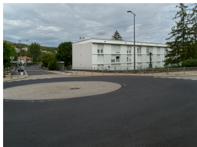
Rond-point à l'extrémité sud de la cité Michelin : vue d'une ancienne croix de carrefour et de l'un des deux immeubles collectifs de la cité.
