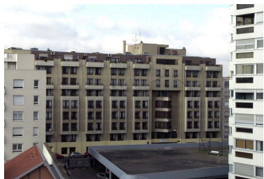
Elévation antérieure, vue partielle Phot. Maryannick Chalabi IVR82_20116904157NUCA
