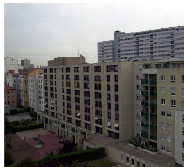
Elévation postérieure, depuis le sud-ouest Phot. Maryannick Chalabi IVR82_20126902468NUC
