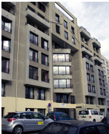
Elévation antérieure, vue partielle depuis le sud-est Phot. Maryannick Chalabi IVR82_20126902467NUC
