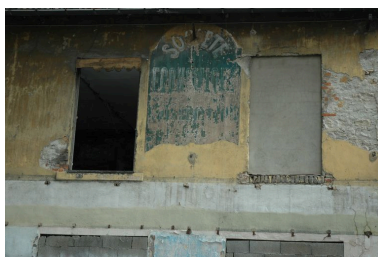
Façade sur la rue Béchevelin, détail de l'enseigne après enlèvement du panneau d'information Phot. Catherine Guégan IVR82_20076900182NUCA
