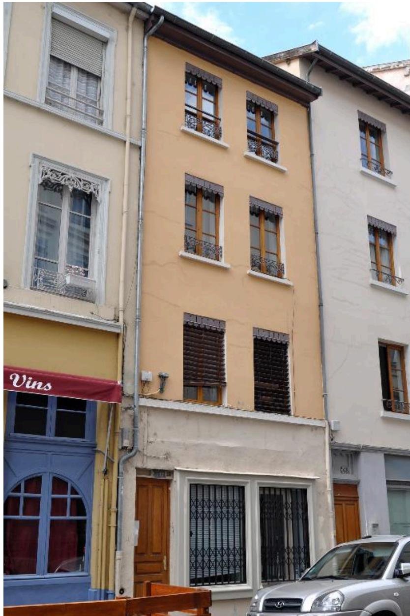
Vue générale, élévation sur rue
