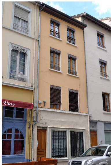
Vue générale, élévation sur rue Phot. Magali Delavenne IVR84_20176901054NUCA
