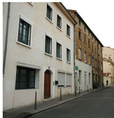
11 et 13 rue Claude-Boyer, façade sur rue Phot. Maryannick Chalabi IVR82_20066901346NUCA
