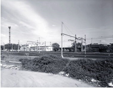
Elévation postérieure depuis la voie ferrée Phot. Eric Dessert IVR82_20026903547V
