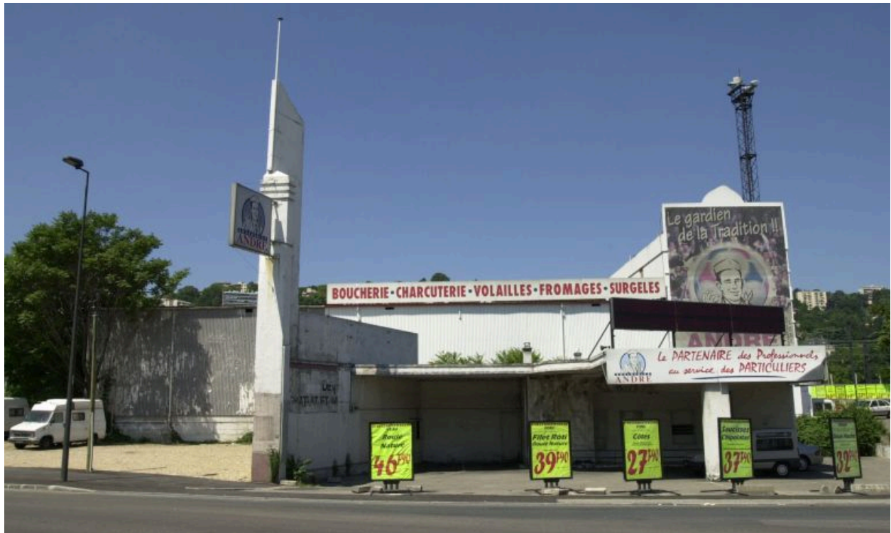
Vue d'ensemble depuis l'est
