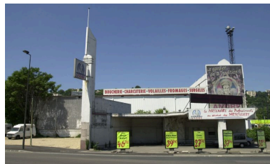
Vue d'ensemble depuis l'est Phot. François Blanchetière IVR82_20016901882NUCA
