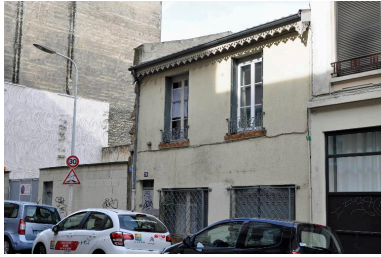
Vue générale, élévation sur rue Phot. Catherine Guégan IVR84_20176901086NUCA
