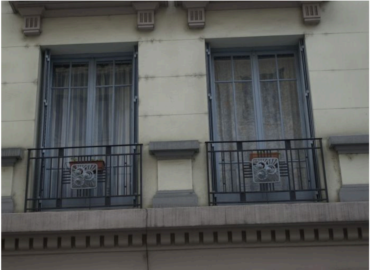
Balconnets du 2e étage
