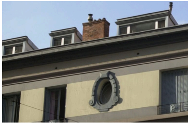
Vue de l'étage de combles Phot. Maryannick Chalabi IVR82_20046903050NUCA
