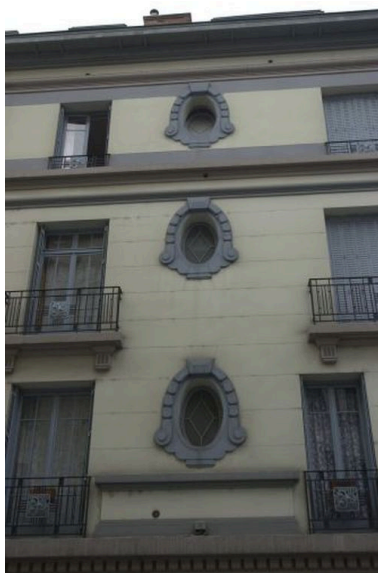
Oculi sur la façade rue de Créqui Phot. Maryannick Chalabi IVR82_20046903048NUCA
