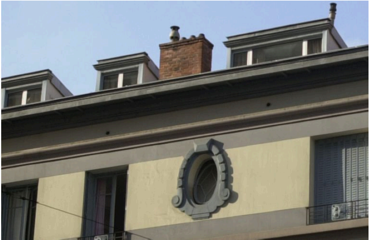
Vue de l'étage de combles
