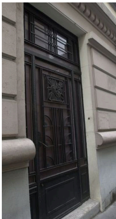
Porte d'entrée 26 rue de Créqui Phot. Maryannick Chalabi IVR82_20046903051NUCA
