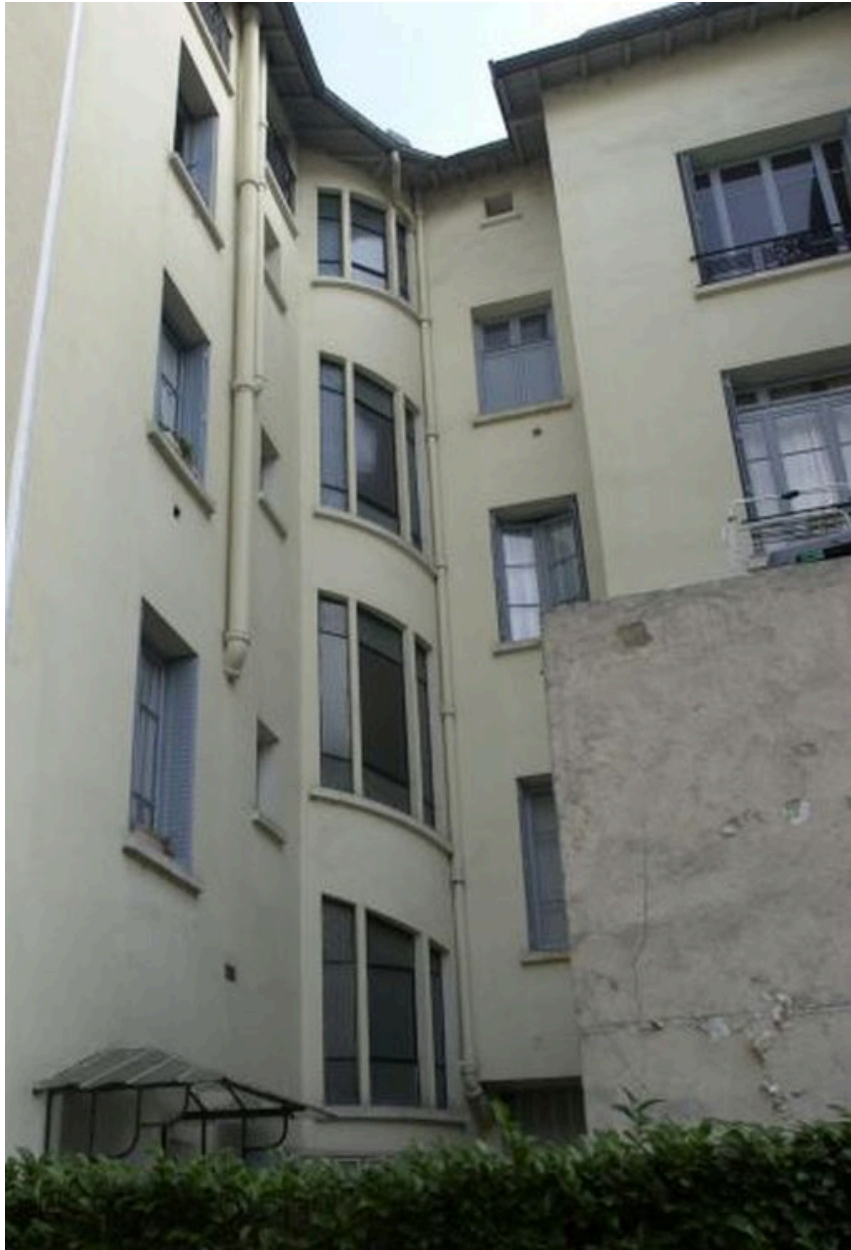
Elévation postérieure : l'escalier construit dans l'angle
