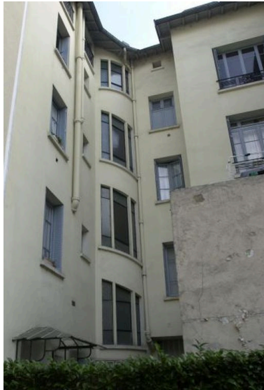
Élévation postérieure : l'escalier construit dans l'angle Phot. Maryannick Chalabi IVR82_20046903606NUCA
