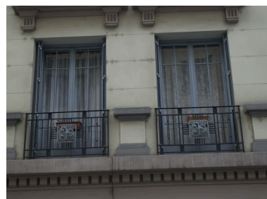
Balconnets du 2e étage Phot. Maryannick Chalabi IVR82_20046903049NUCA
