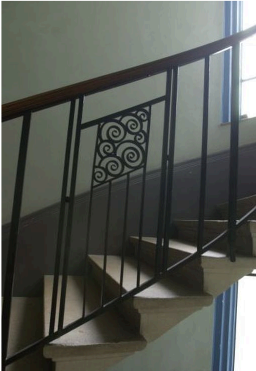
Détail de la rampe d'escalier
