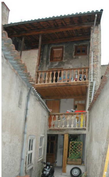
Elévation sur cour. Phot. Simone Hartmann-Nussbaum IVR82_20124201346NUCA
