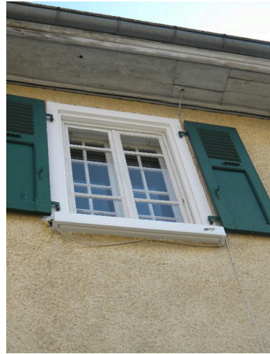
Détail d'une fenêtre double. Phot. Jérôme Daviet IVR82_20137401168NUCA
