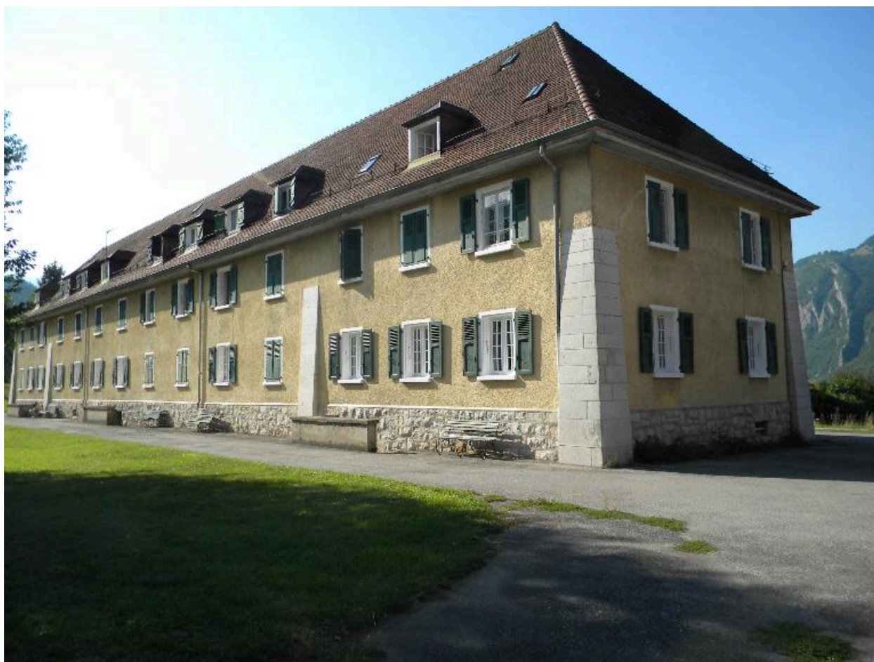
Vue de la façade arrière.
