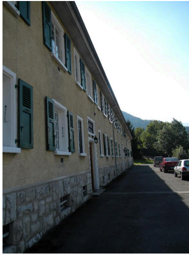
Détail de la façade principale. Phot. Jérôme Daviet IVR82_20137401167NUCA
