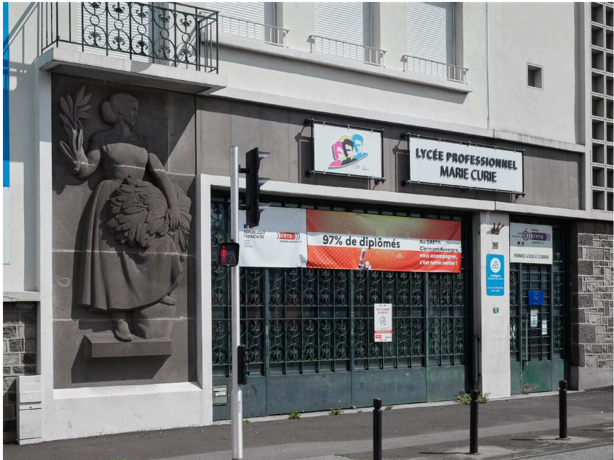
Vue d'ensemble, à côté de l'entrée principale sur le boulevard
