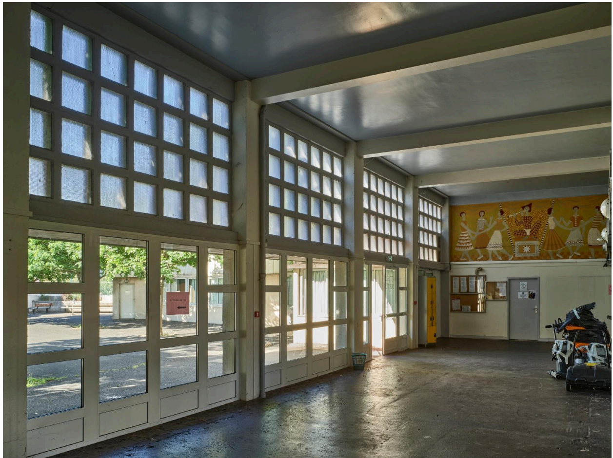
Vue générale de la salle haute dite préau, avec peinture murale côté ouest.
