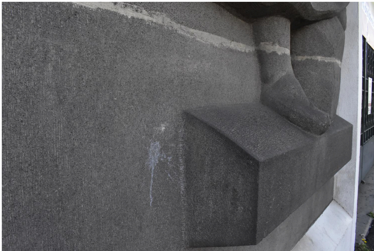
Détail du haut-relief représentant l'Abondance. Traces de bouchardage et layures (ou hachures).
