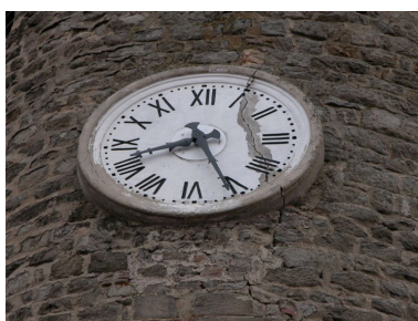
Détail d'un des cadrans extérieurs de la tour. Phot. Thierry Monnet IVR82_20134203338NUCA
