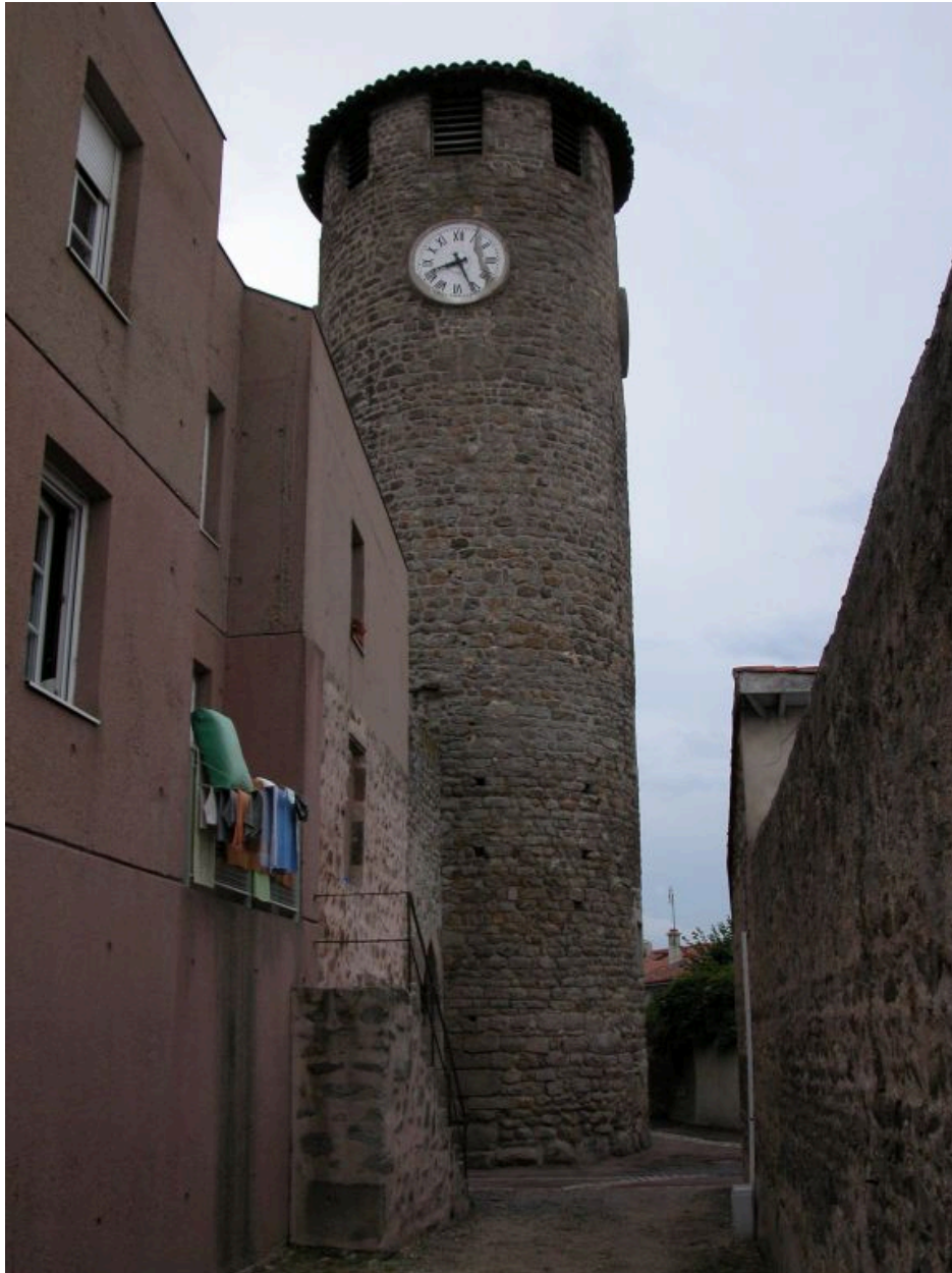
Vue d'ensemble de la tour depuis le nord.
