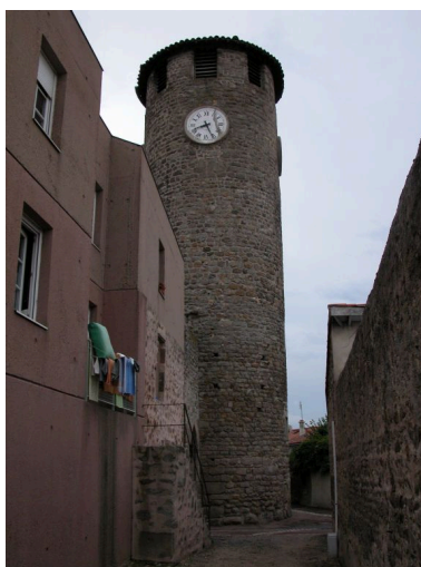
Vue d'ensemble de la tour depuis le nord. Phot. Thierry Monnet IVR82_20134203335NUCA
