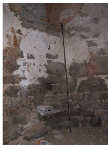
Niveau 1, sol en terre battue, détail de la maçonnerie, base baie haute. Phot. Thierry Monnet IVR82_20134203339NUCA
