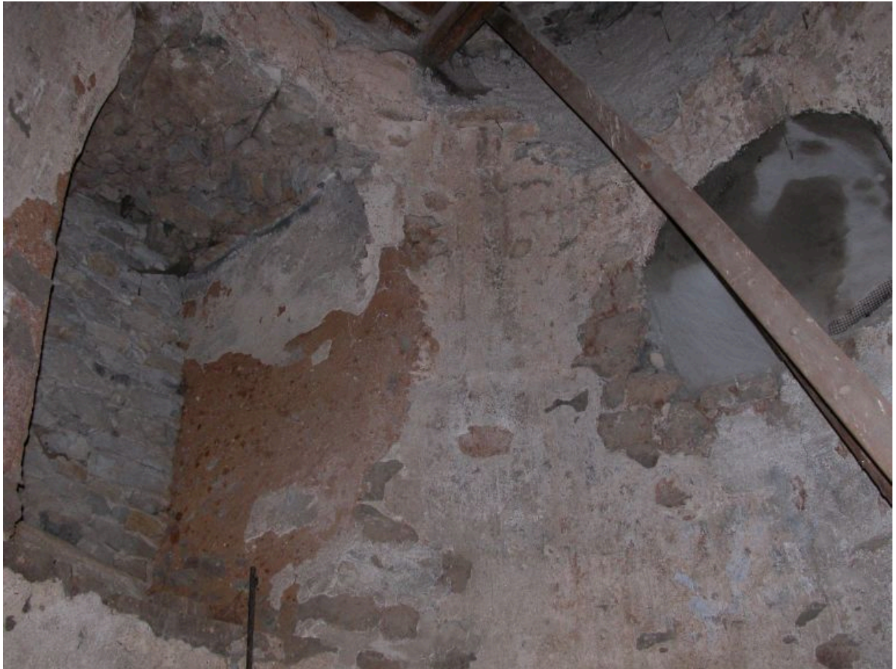
Niveau1, baie haute et échelle d'accès au niveau 2.
