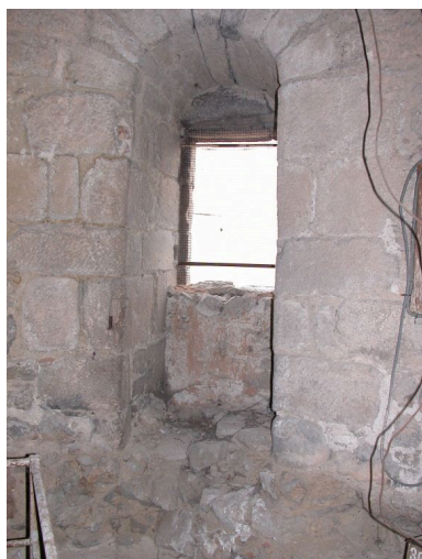
Niveau 2, baie en plein-cintre ouvrant sur l'intérieur des remparts, vers la porte. Phot. Thierry Monnet IVR82_20134203343NUCA
