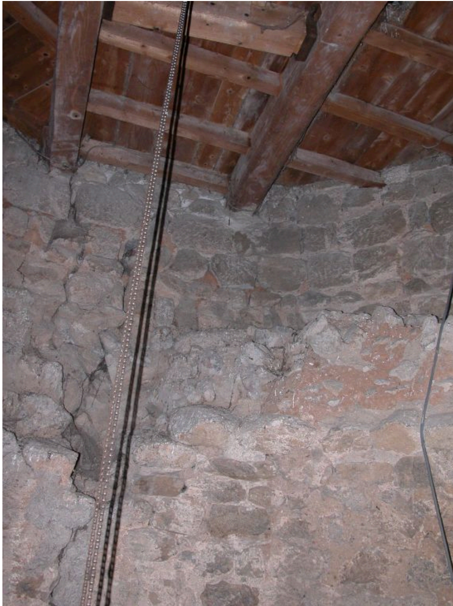
Niveau 3, traces d'arrachement de la voûte.
