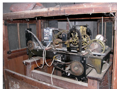
Niveau 4, système d'horlogerie, face avant. Phot. Thierry Monnet IVR82_20134203348NUCA
