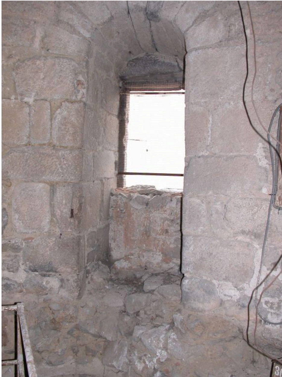
Niveau 2, baie en plein-cintre ouvrant sur l'intérieur des remparts, vers la porte.
