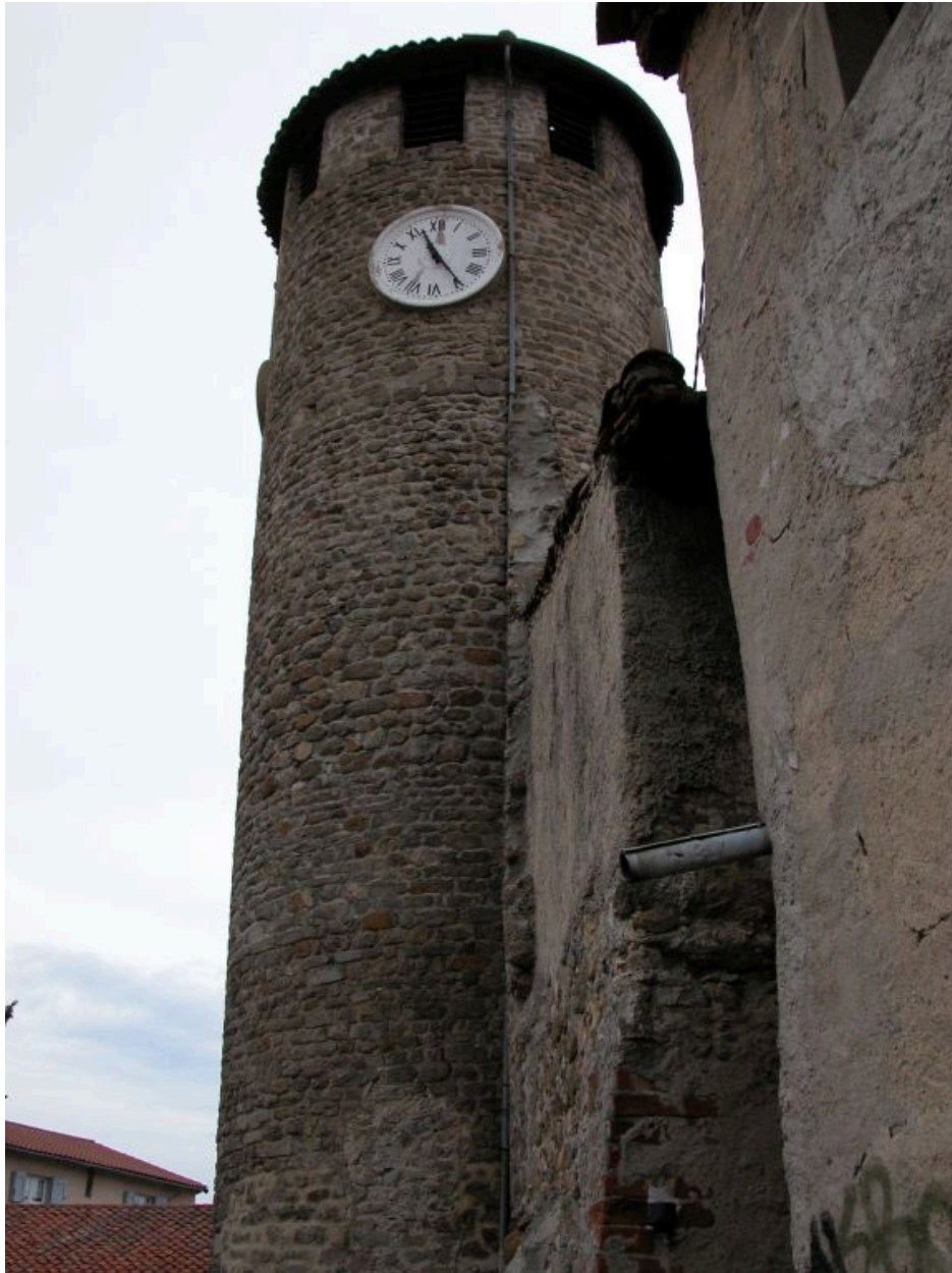
Vue partielle de la tour depuis le sud.
