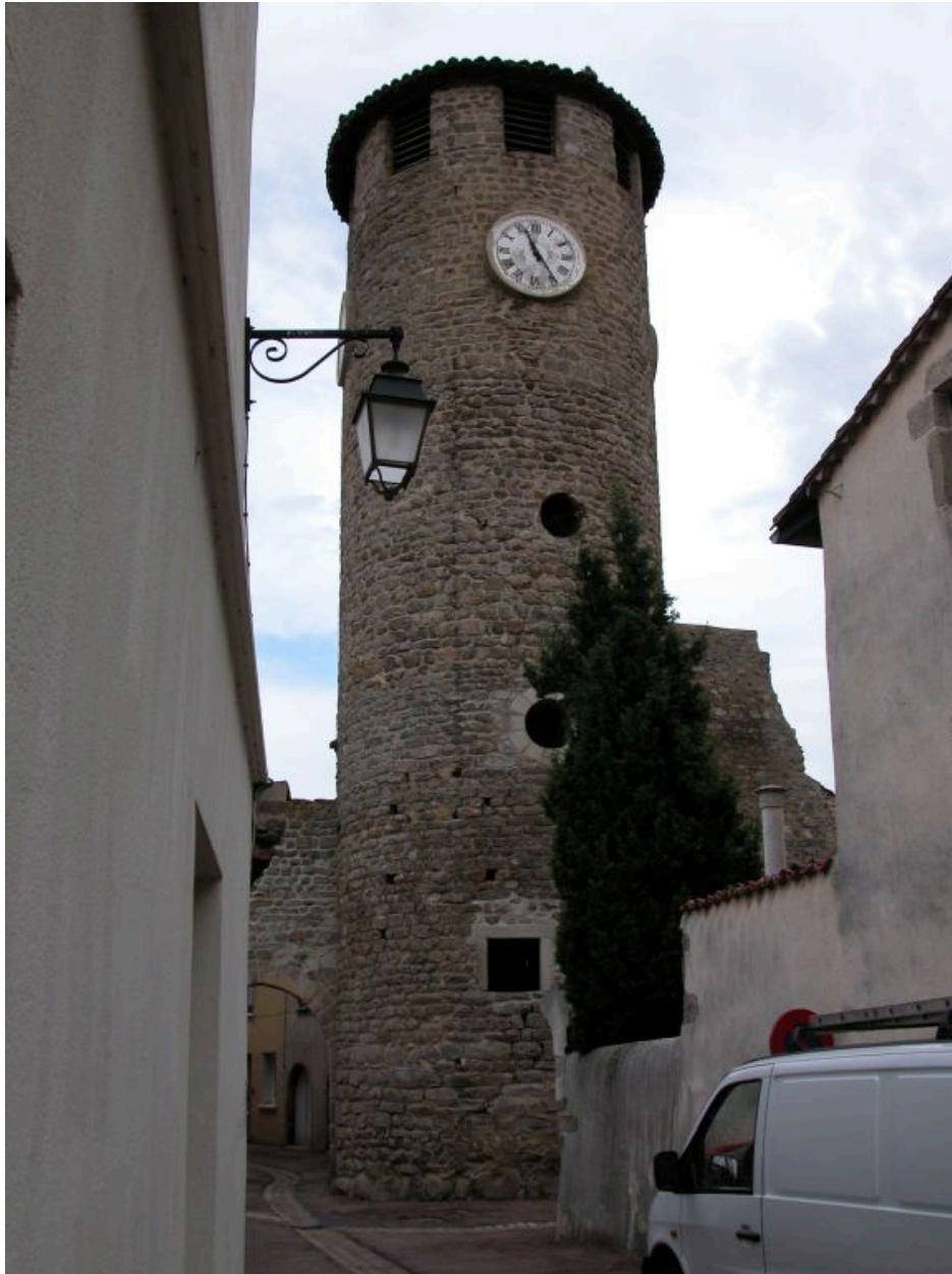
Vue d'ensemble de la tour depuis l'ouest.
