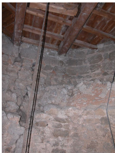
Niveau 3, traces d'arrachement de la voûte. Phot. Thierry Monnet IVR82_20134203346NUCA
