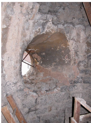
Niveau 3, oculus. Phot. Thierry Monnet IVR82_20134203344NUCA
