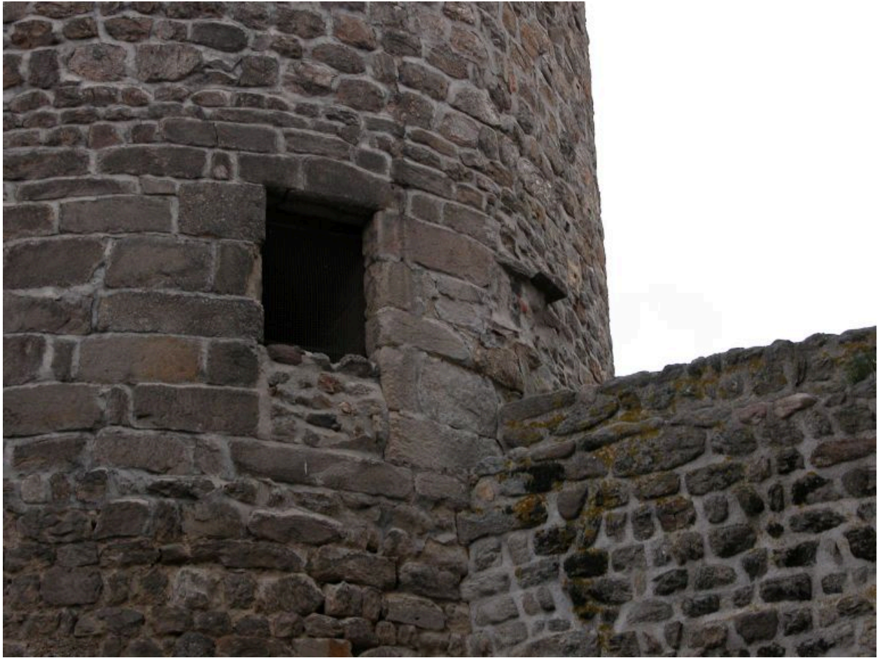
Détail de la porte haute d'entrée dans la tour, côté est.
