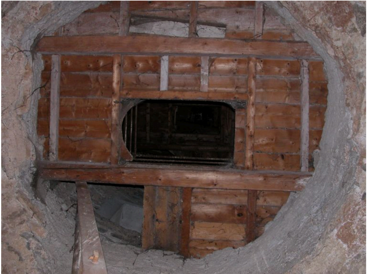
Plancher niveau 2. Enfilade des niveaux supérieurs.
