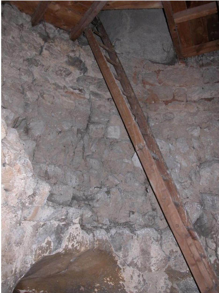
Niveau 3, partie haute de l'oculus, échelle d'accès au niveau 4.
