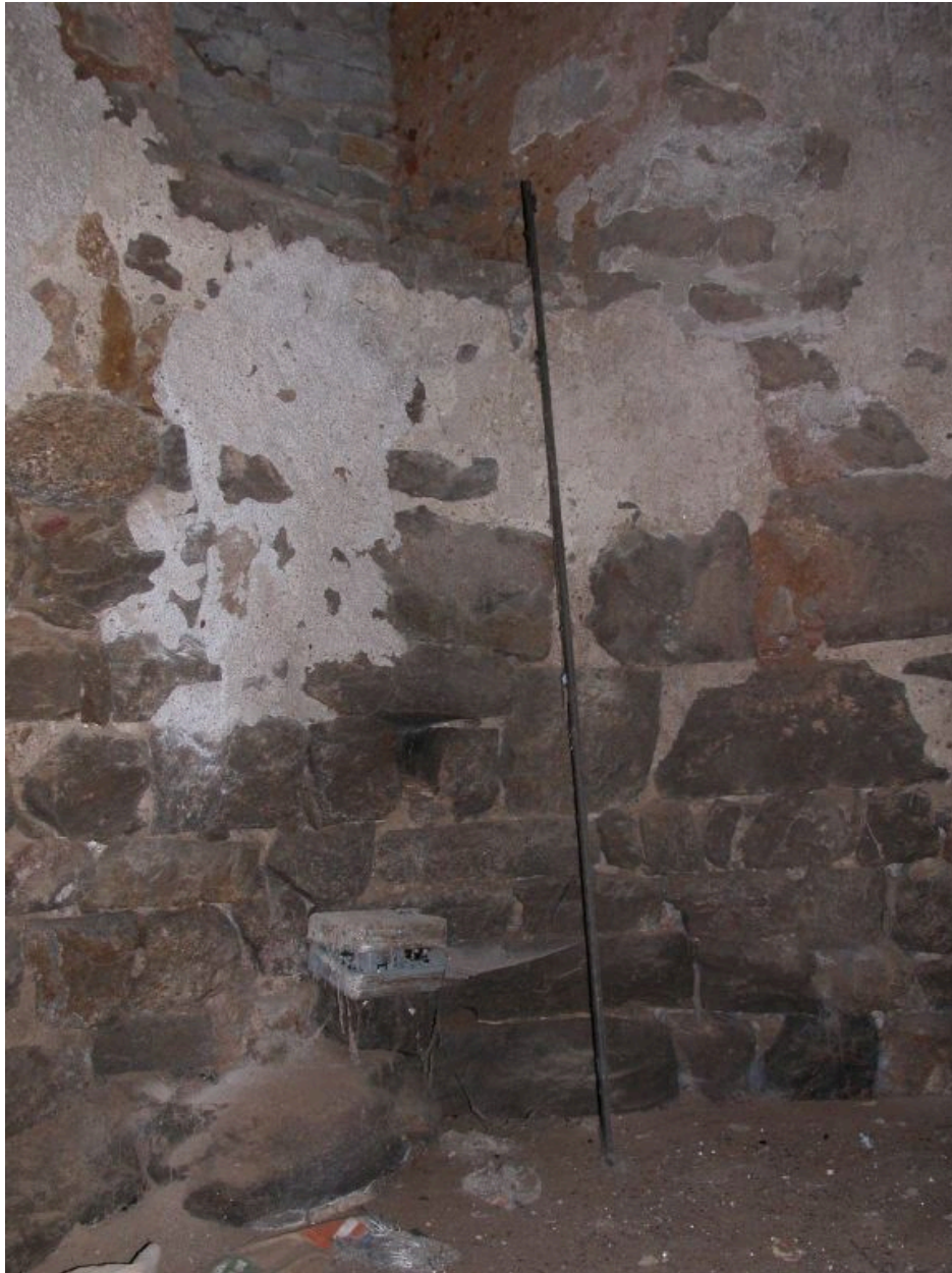
Niveau 1, sol en terre battue, détail de la maçonnerie, base baie haute.
