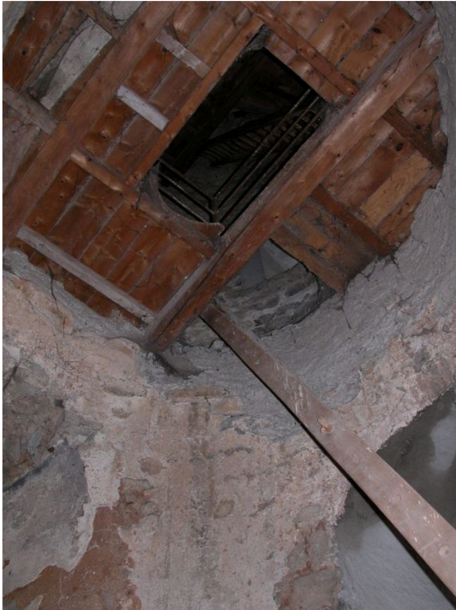
Niveau 1, partie supérieure baie haute, plancher du niveau 2.
