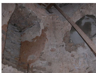
Niveau 1, baie haute et échelle d'accès au niveau 2. Phot. Thierry Monnet IVR82_20134203340NUCA
