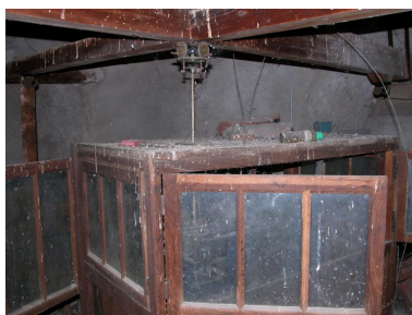
Niveau 4, coffre de l'horloge. Phot. Thierry Monnet IVR82_20134203347NUCA
