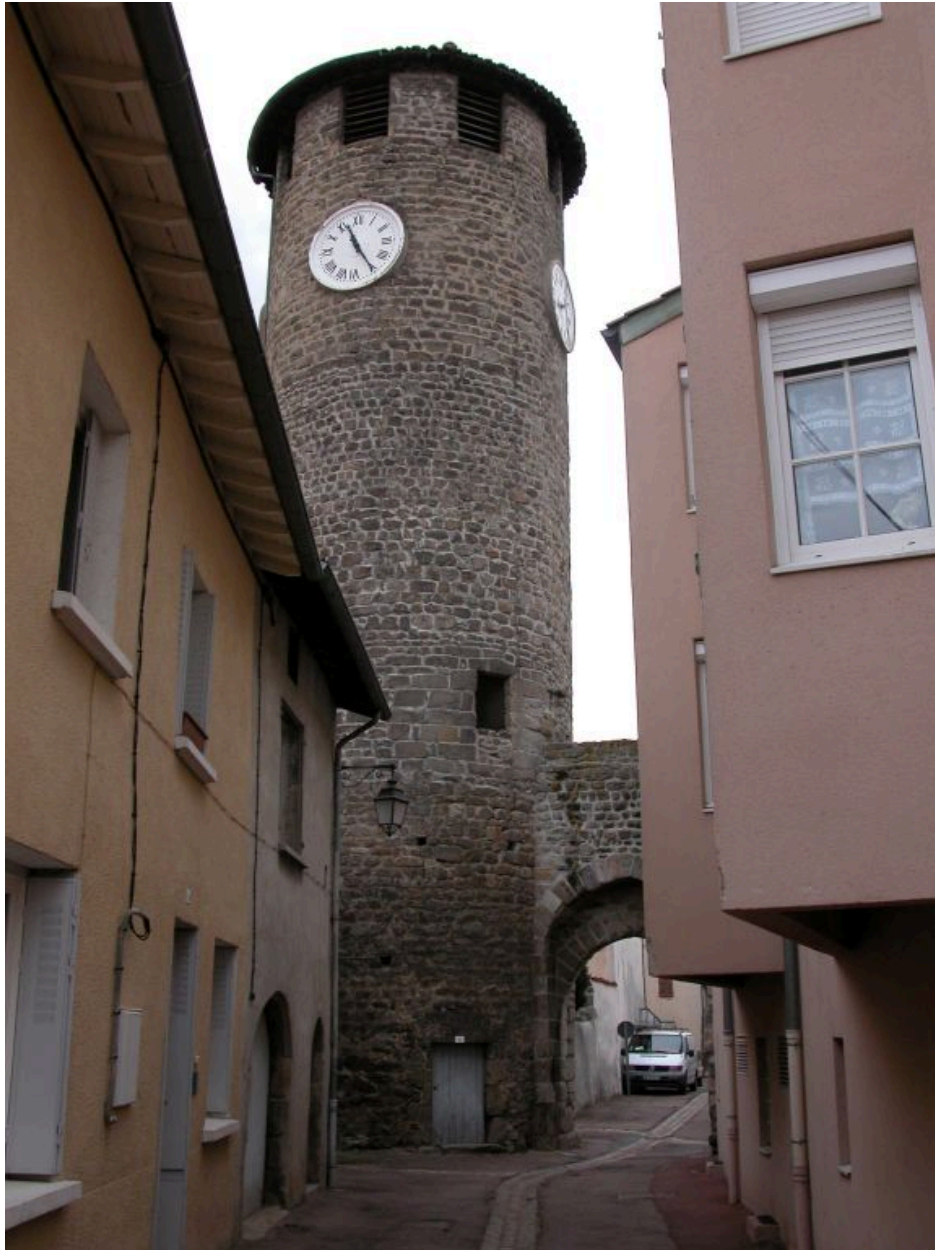
Vue générale de la tour depuis l'est.
