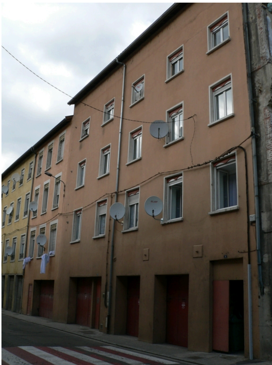
Façade principale sur rue
