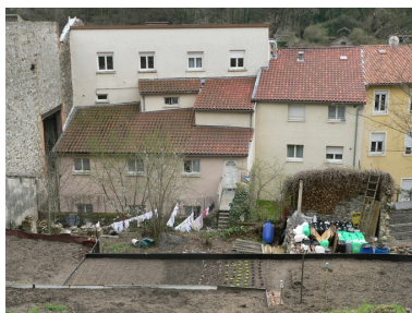
Façade arrière Phot. Isabelle Dupuis IVR82_20093800419NUCA
