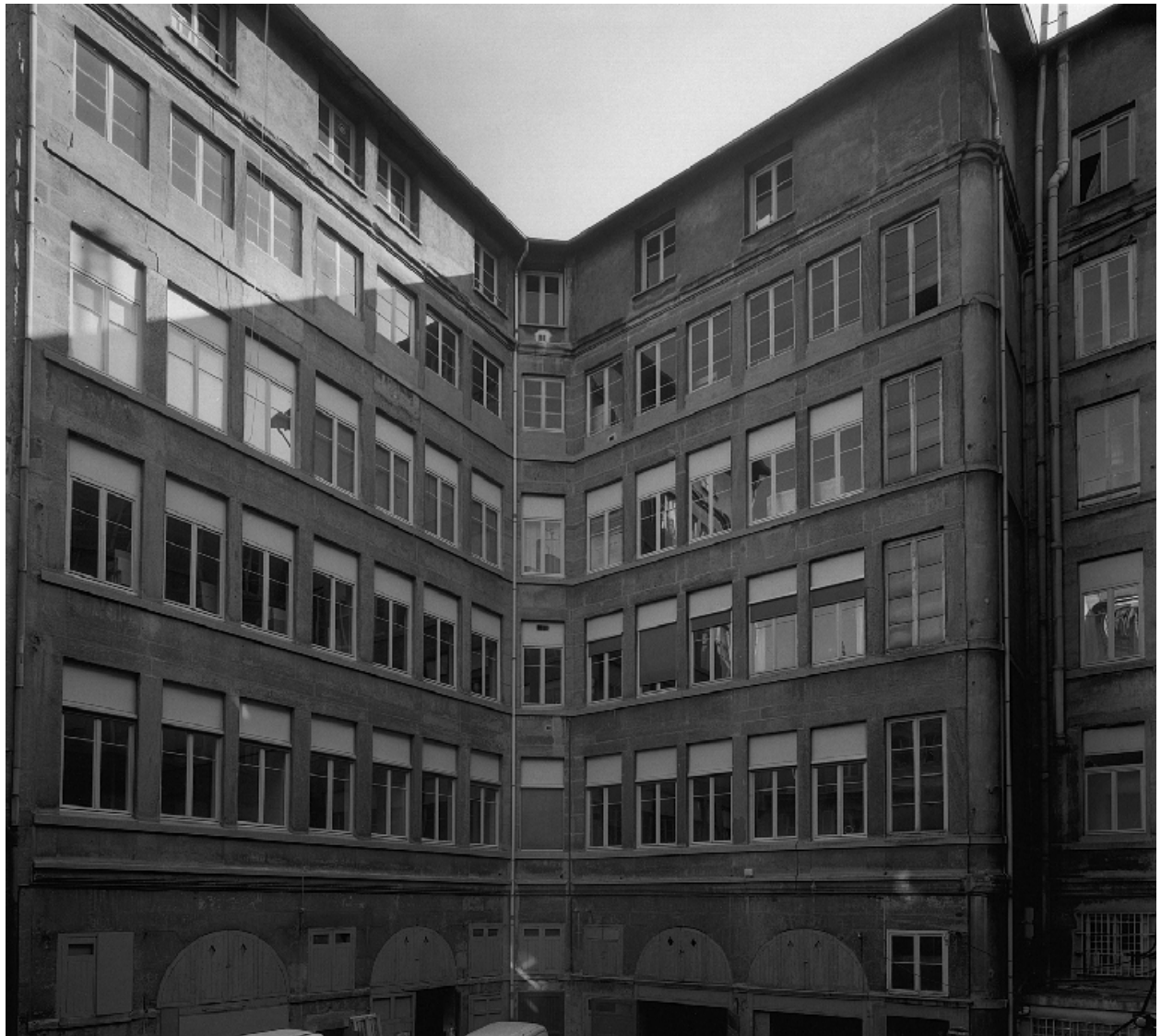
Façade sur cour
