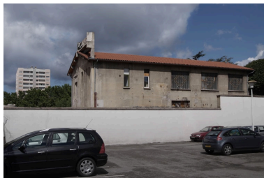
Vue générale est Phot. Géraldine Millo IVR82_20076901808NUCA
