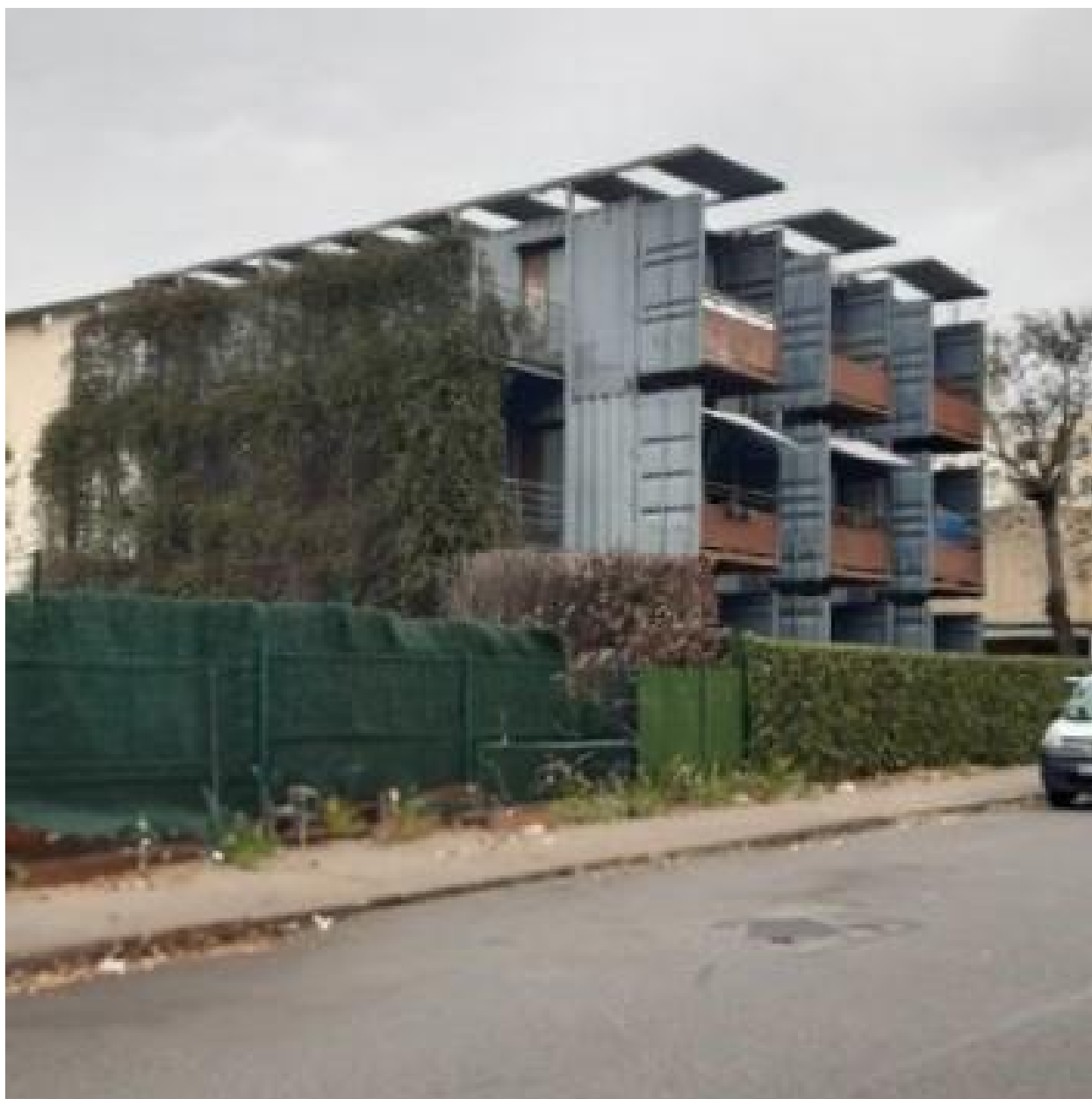
Vue sud-ouest des logements temporaires : containers maritimes
