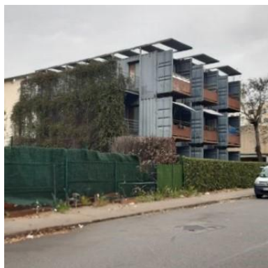
Vue sud-ouest des logements temporaires : containers maritimes Phot. Nadine Halitim-Dubois IVR84_20256901436NUCA
