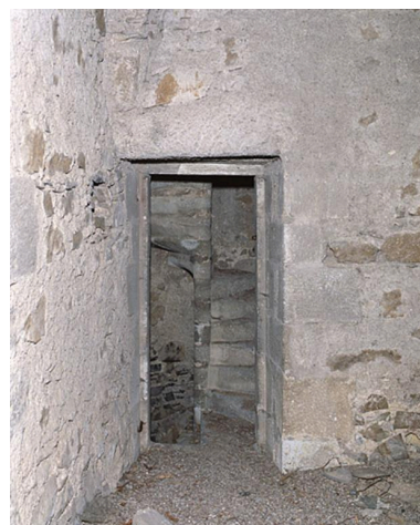
L'escalier en vis de la tour du clocher, depuis la salle du premier étage. Phot. Jean-Michel Périn IVR83_20086300158XA
