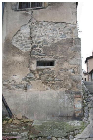
Détail de l'ancienne sacristie, accolée au nord-est de l'église dans le courant du 19e siècle ; elle a englobé dans sa maçonnerie un probable vestige de l'ancienne porte de ville Saint- Jean (photographie chercheur). Phot. Brigitte Ceroni IVR83_20076300708NUCA
