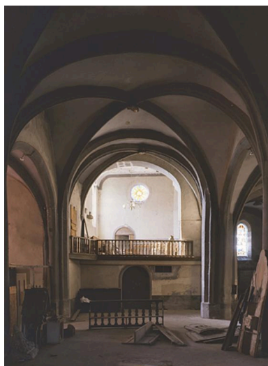
La nef centrale en direction de la tribune, côté ouest. Phot. Jean-Michel Périn IVR83_20086300129XA
