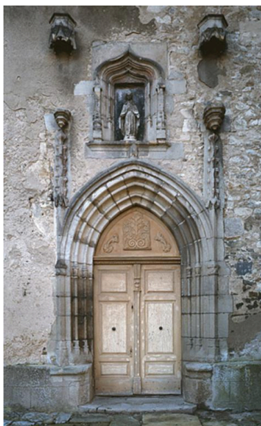
Portail de l'élévation nord de l'église. Phot. Jean-Michel Périn IVR83_20086300127XA
