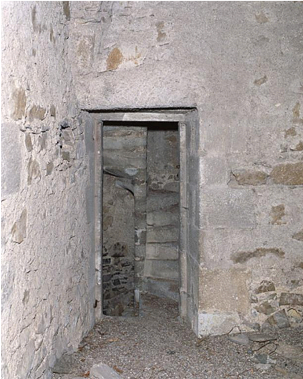
L'escalier en vis de la tour du clocher, depuis la salle du premier étage.
