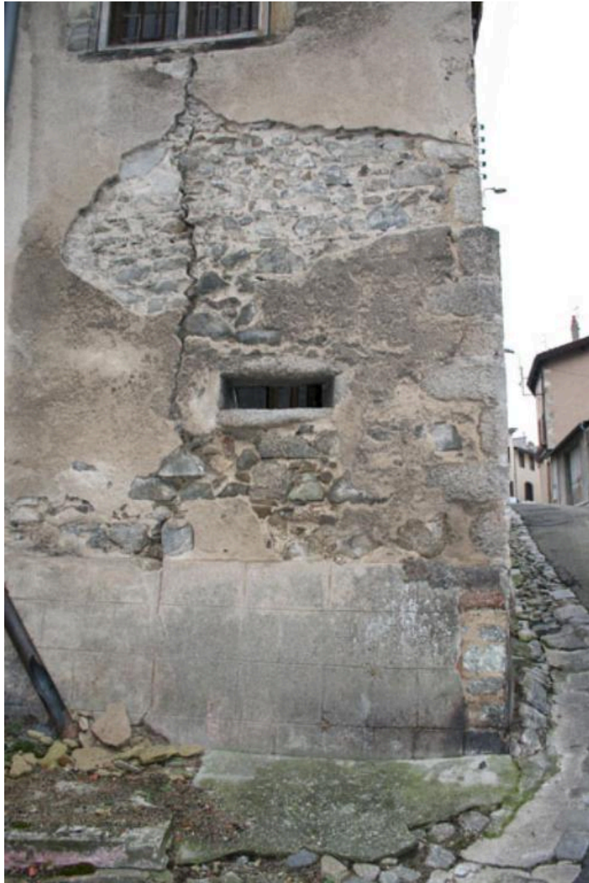
Détail de l'ancienne sacristie, accolée au nord-est de l'église dans le courant du 19 e siècle ; elle a englobé dans sa maçonnerie un probable vestige de l'ancienne porte de ville Saint-Jean (photographie chercheur).
