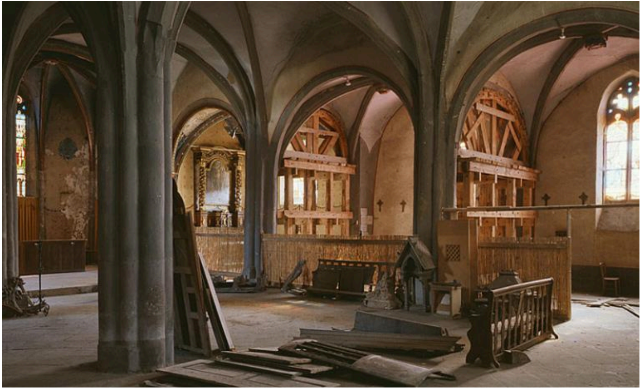
Le collatéral sud, vu de trois-quarts, en partie étayé pour prévenir son effondrement.
