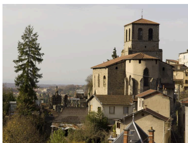
L'église et le cimetière, depuis l'est. Phot. Jean-Michel Périn IVR83_20096300404NUC4A
