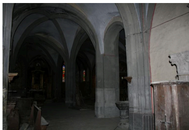
A droite (au niveau du bénitier), un arc en plein cintre, vestige de l'église romane (photographie chercheur). Phot. Brigitte Ceroni IVR83_20076300705NUCA
