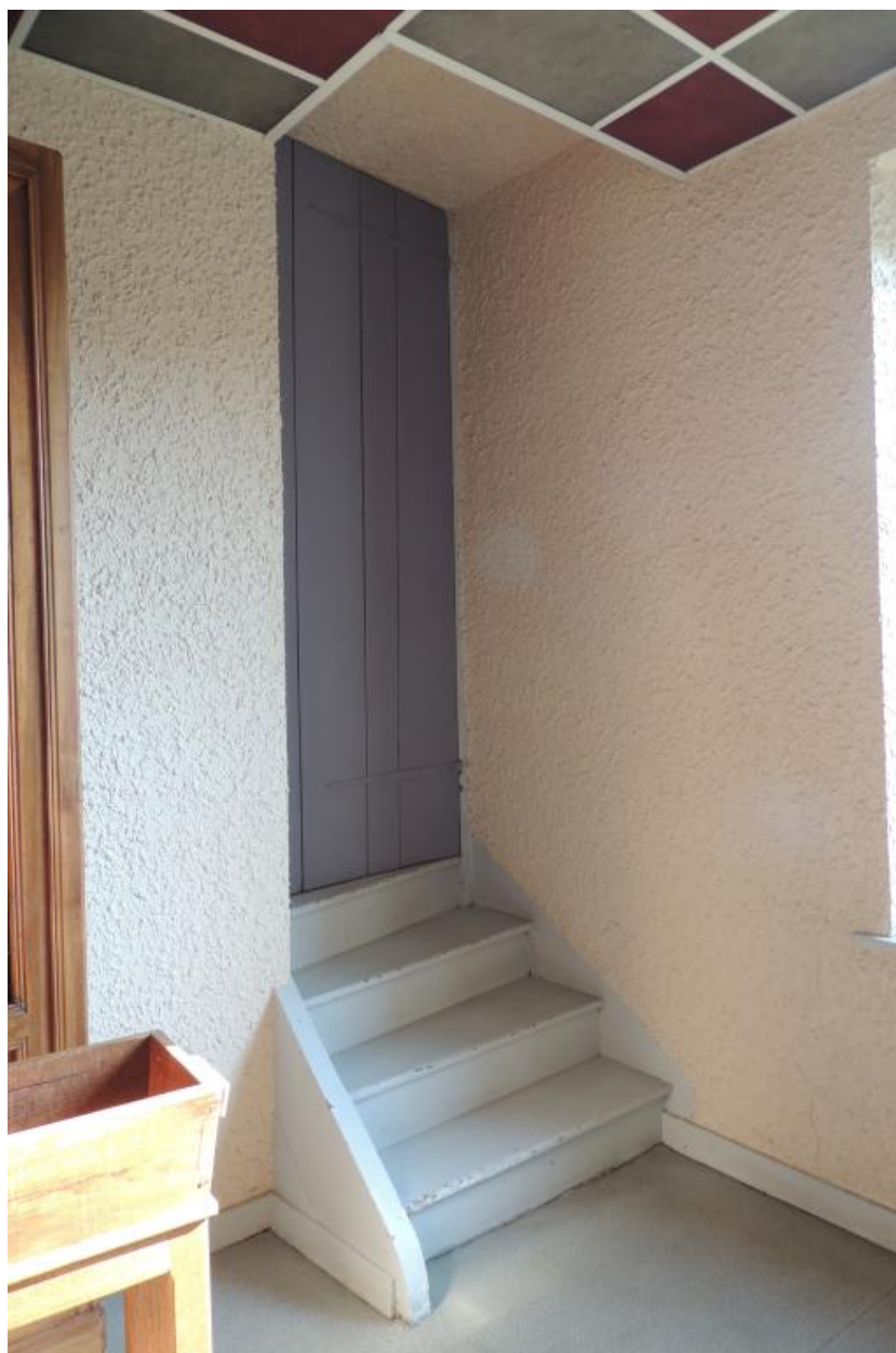
Départ de l'escalier intérieur menant aux combles.
