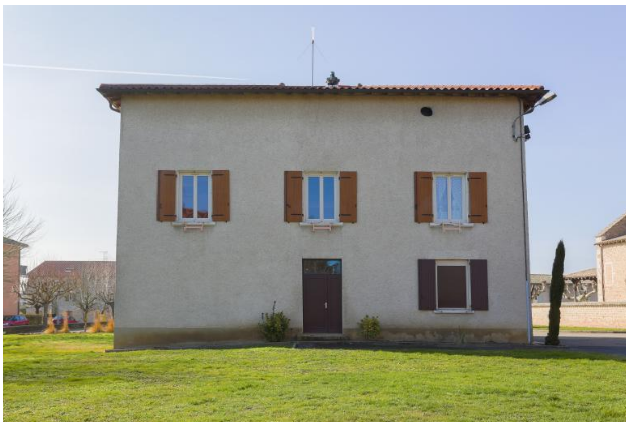
Façade orientale, état actuel.
