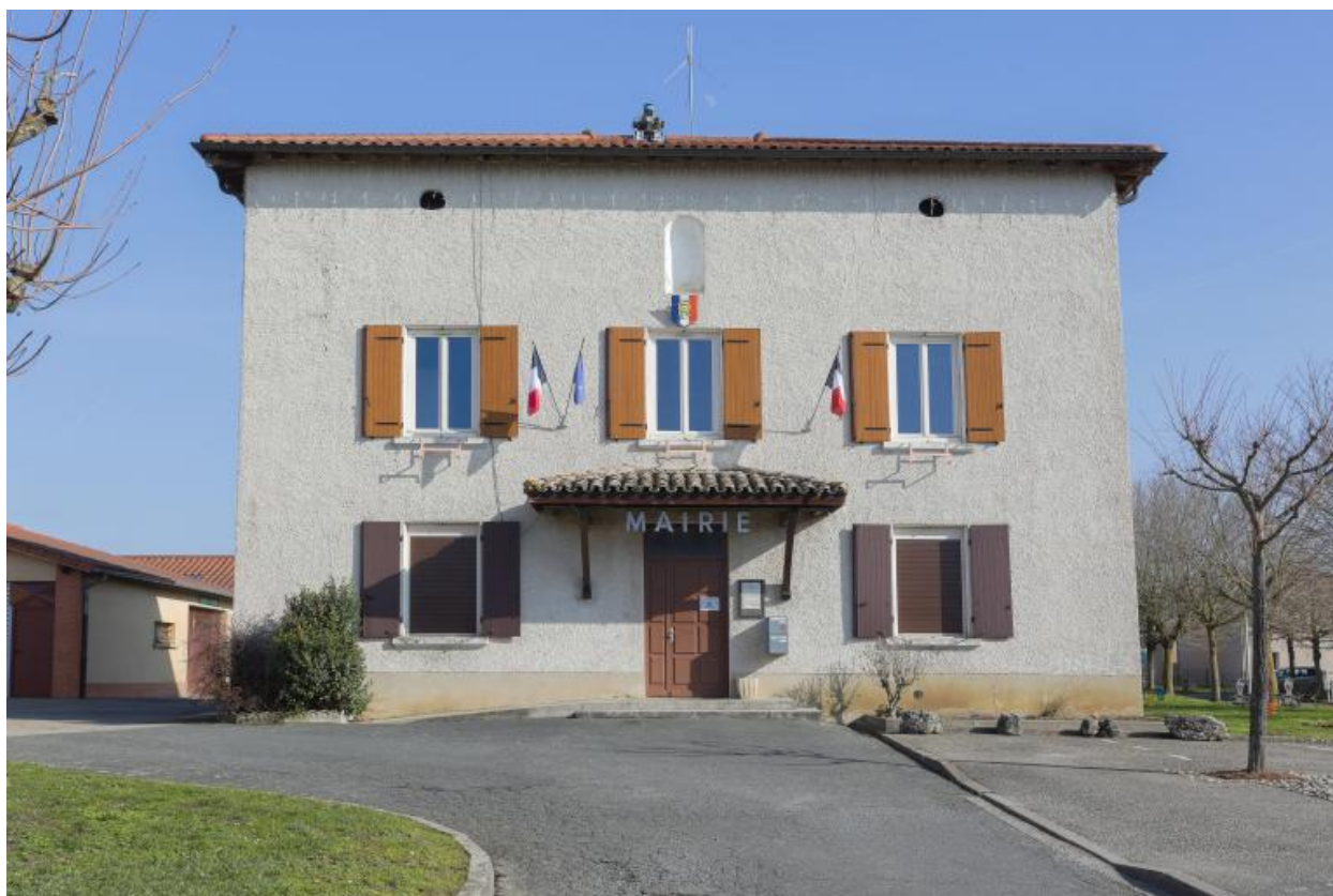
Façade occidentale, état actuel.
