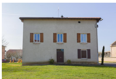
Façade orientale, état actuel. Phot. Kevin Dandel IVR84_20190100319NUCA
