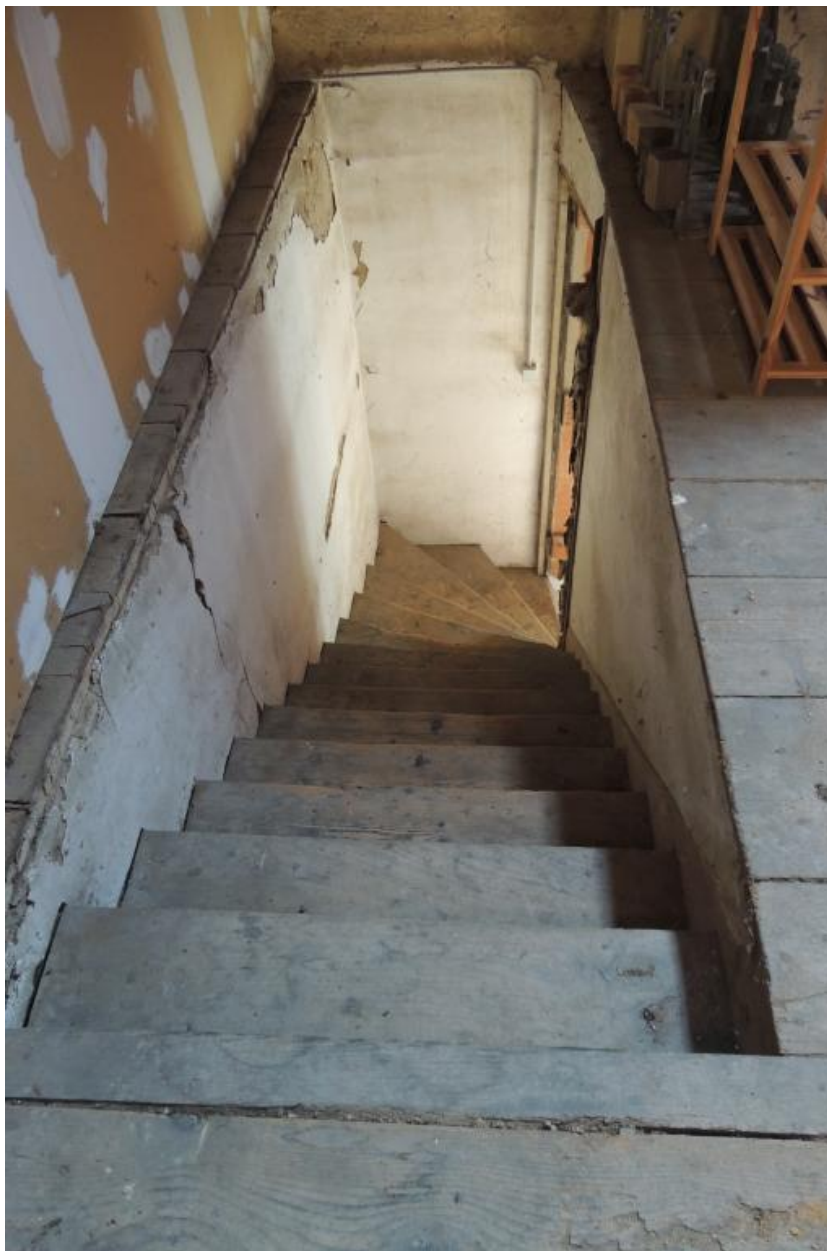
Escalier intérieur menant aux combles.
