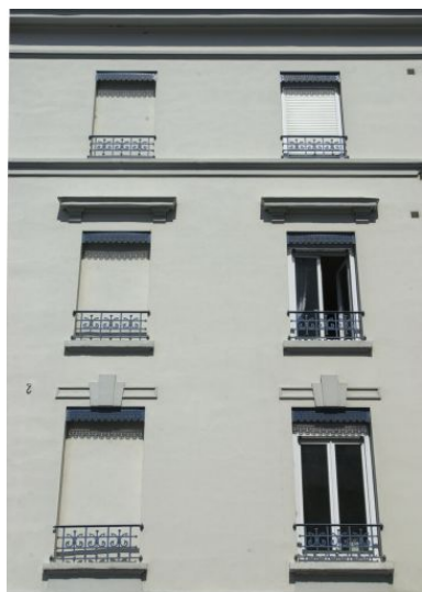
Détail des fenêtres Phot. François Blanchetière IVR82_20016902031NUCA
