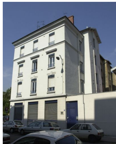
Elévations latérale rue Delandine et postérieure sur cour Phot. François Blanchetière IVR82_20016902030NUCA
