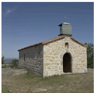
Vue d'ensemble de trois-quarts, depuis l'ouest. Phot. Eric Dessert IVR82_20064201979NUCA
