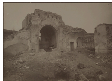
Vue partielle de l'église en ruine, choeur et chapelle nord. Papier fin, tons rosés (citrate ?), fort curling au réchauffement. Plaques de 17,2x12. B Diana Montbrison. Fonds Brassart, cote 5081 Phot. Eric (reproduction) Dessert, Autr. Brassart IVR82_20084200200NUCA
