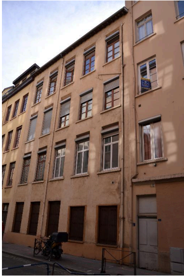
Vue d'ensemble façade nord Phot. Noémie Caillat IVR82_20156900261NUCA
