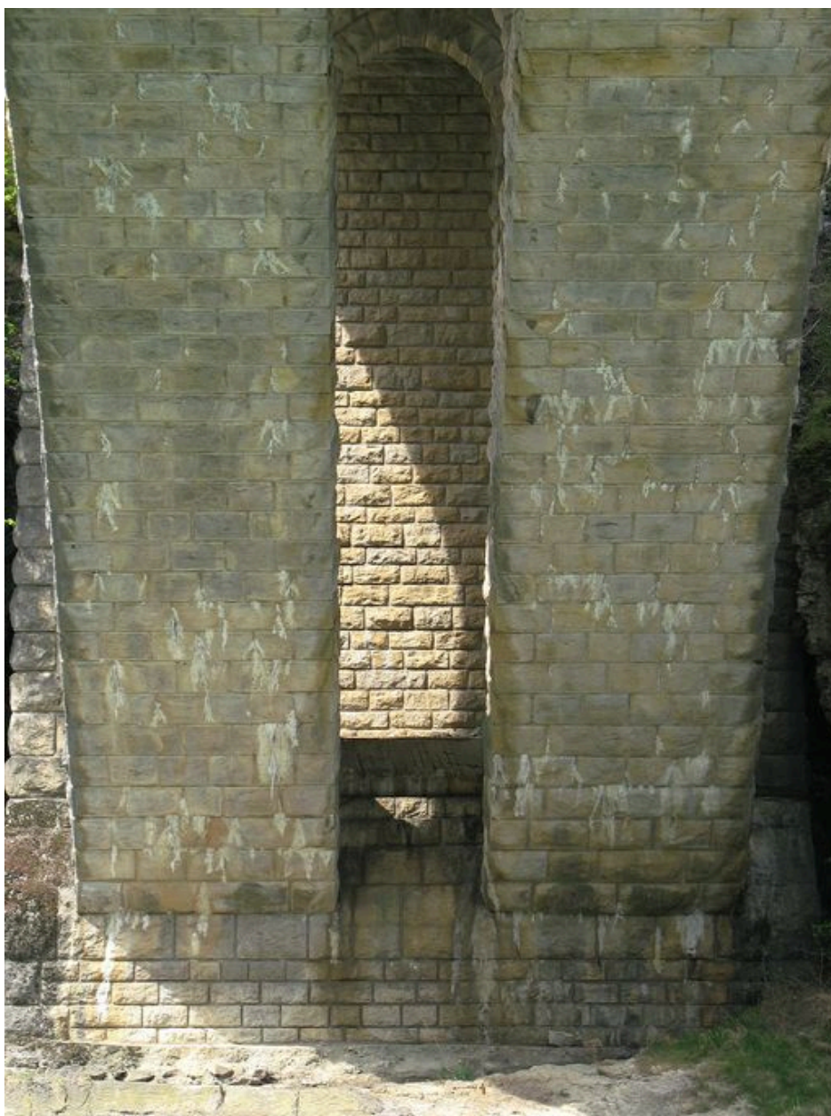
Dessous de l'arche : vue partielle, rive droite
