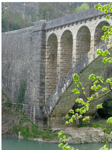
Vue partielle face amont : culée rive gauche Phot. I. Havard IVR82_20097301503NUCA
