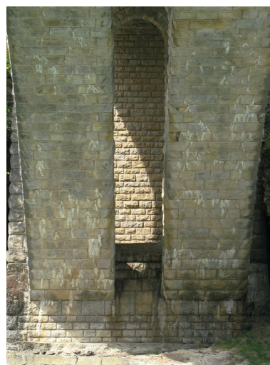
Dessous de l'arche : vue partielle, rive droite Phot. I. Havard IVR82_20097301511NUCA
