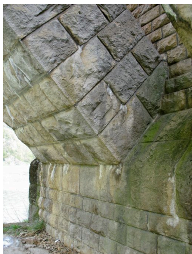
Sous le pont, rive gauche : retombée de l'arche, vue partielle Phot. I. Havard IVR82_20097301512NUCA
