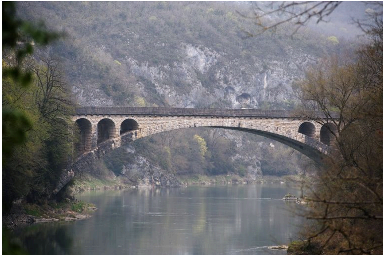
Vue de la face aval
