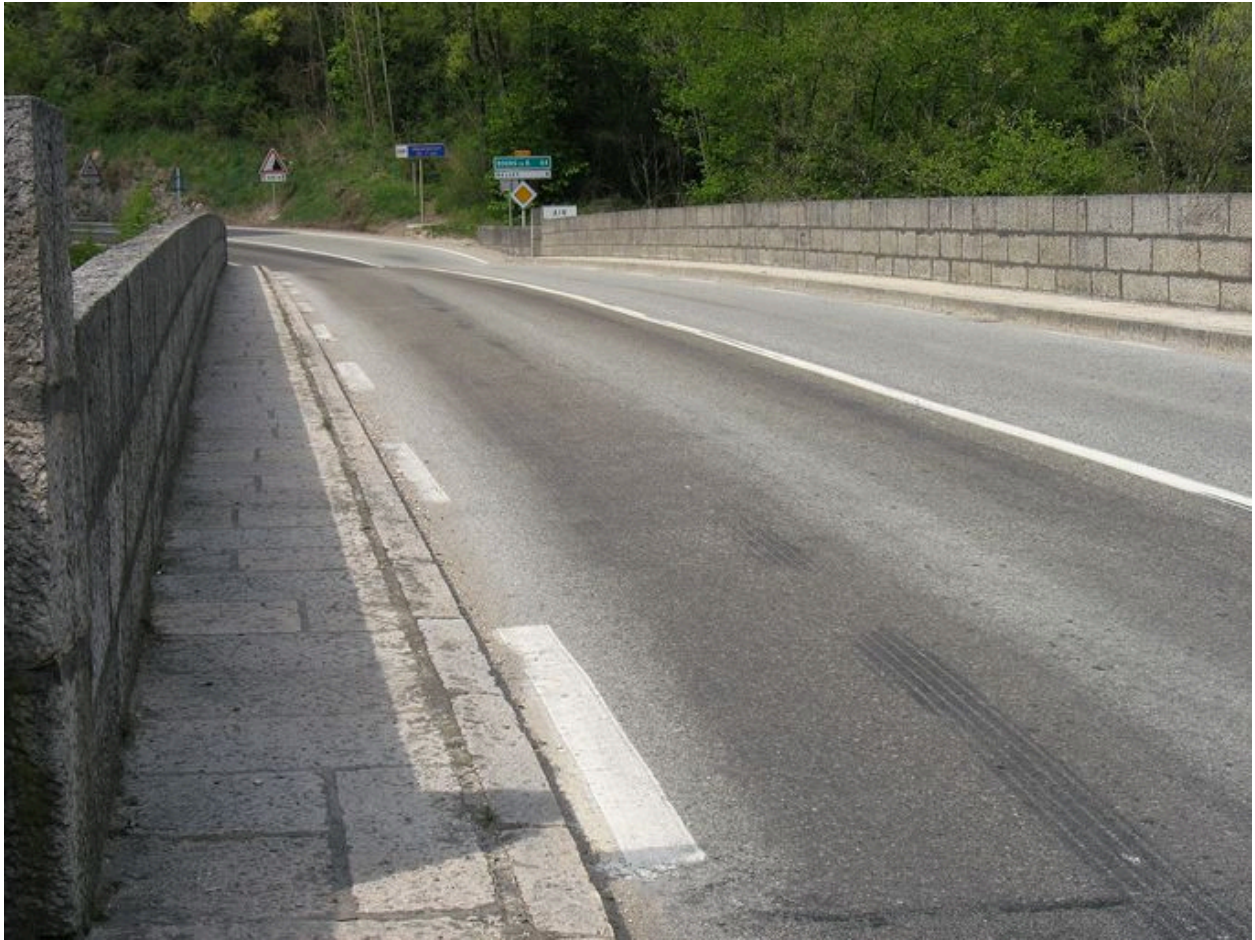
Vue de la chaussée
