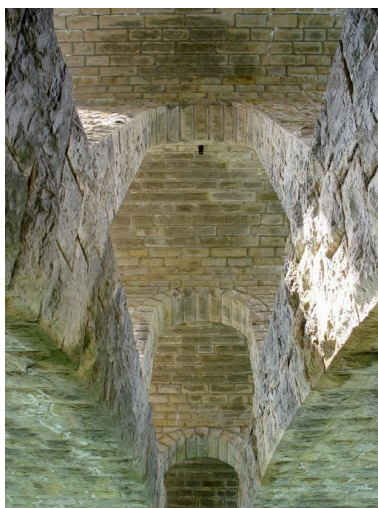
Dessous du tablier : vue partielle Phot. I. Havard IVR82_20097301513NUCA
