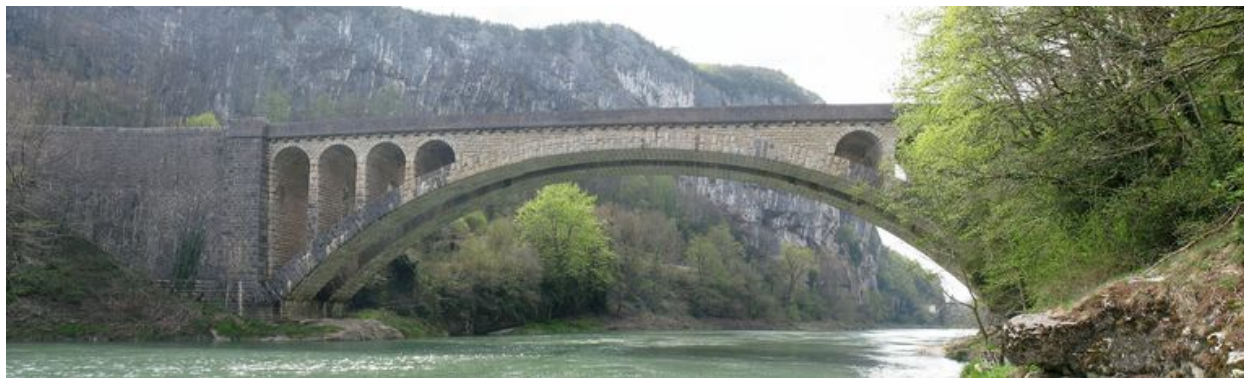
Vue panoramique, face amont
