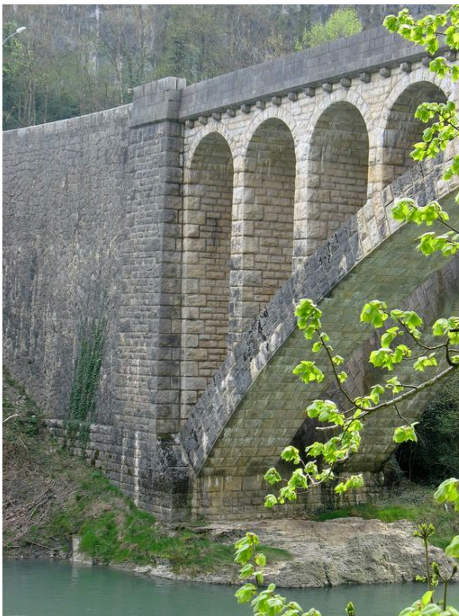
Vue partielle face amont : culée rive gauche
