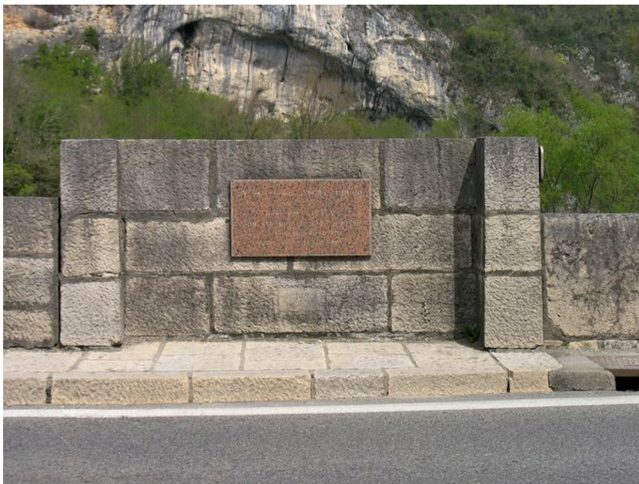
Sur le tablier : vue du refuge avec inscriptions portées
