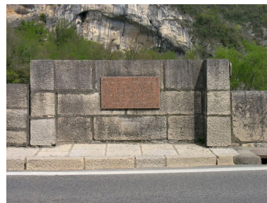
Sur le tablier : vue du refuge avec inscriptions portées Phot. I. Havard IVR82_20097301508NUCA
