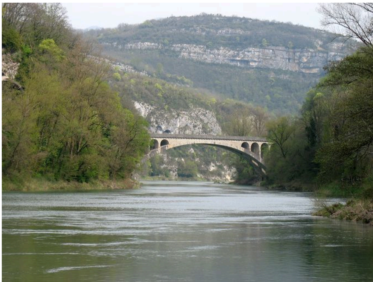
Vue du pont dans le site, face aval
