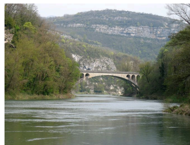
Vue du pont dans le site, face aval Phot. I. Havard IVR82_20097301514NUCA
