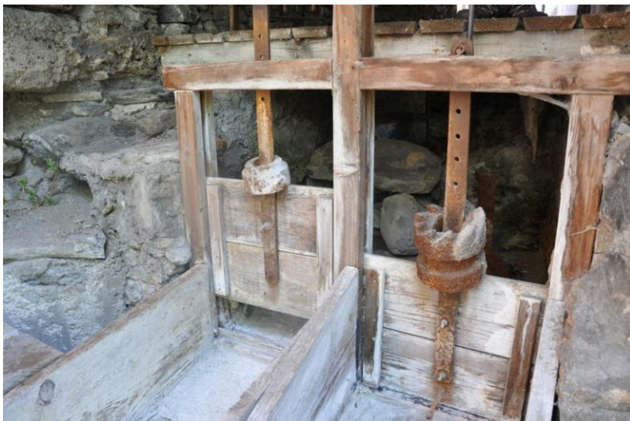
Vannes du coursier alimentant la roue
