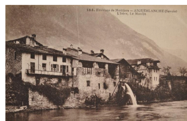
Vue du moulin, début XXe siècle (© Collection particulière M.-A. Podevin). IVR84_20167306422NUCA
