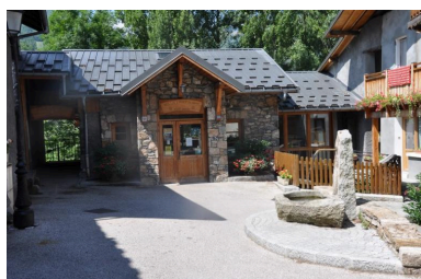
Vue du moulin à huile restauré. Phot. Clara Bérelle IVR84_20167306407NUCA
