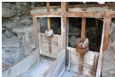
Vannes du coursier alimentant la roue
