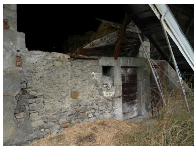
Détail de la façade est. Phot. Jérôme Daviet IVR82_20107304003NUCA
