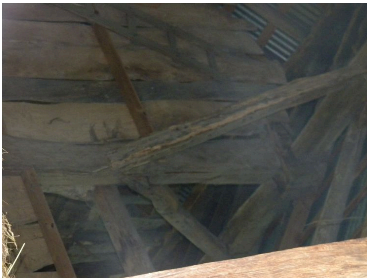
Détail de la charpente.
