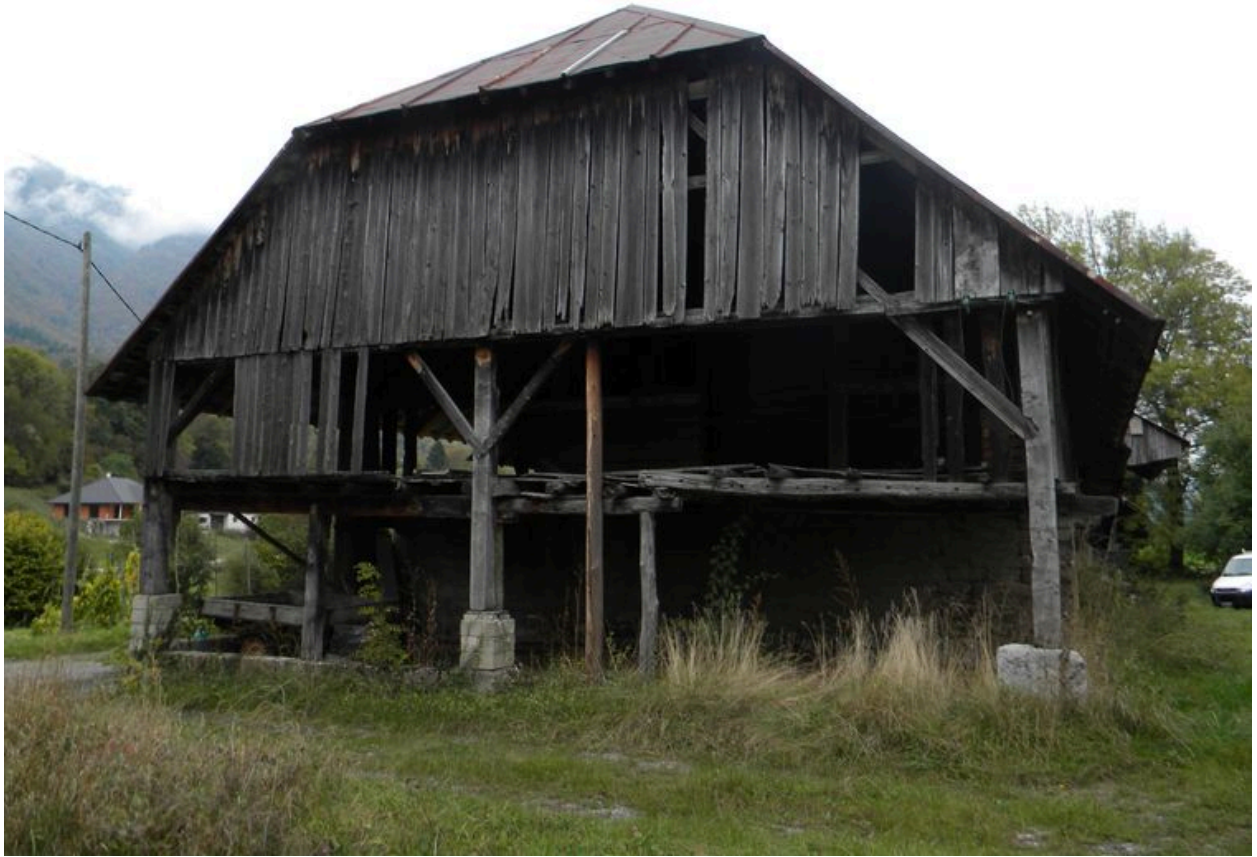
Vue de la partie couverte en façade sud.
