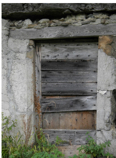
Encadrement de porte avec linteau bois et piedroits de rempli. Phot. Jérôme Daviet IVR82_20107304004NUCA
