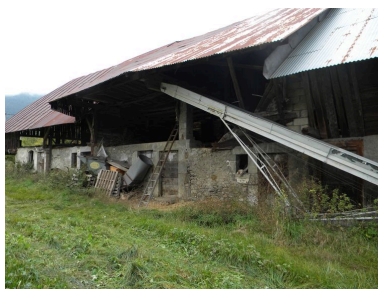
Partie nord de la façade est. Phot. Jérôme Daviet IVR82_20107304009NUCA
