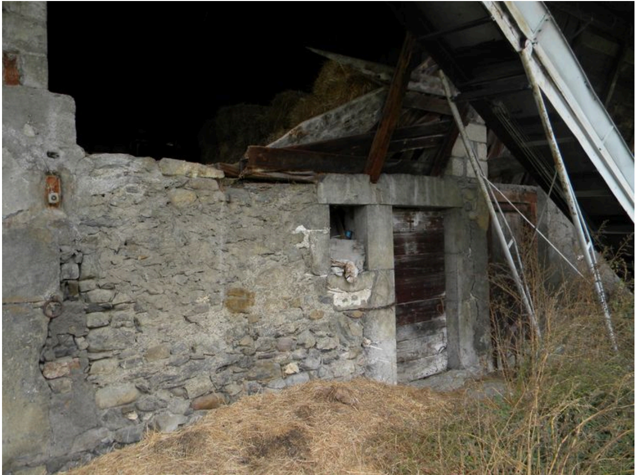
Détail de la façade est.
