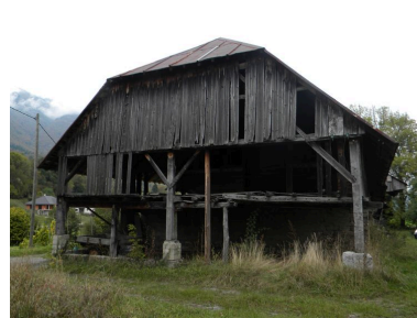
Vue de la partie couverte en façade sud. Phot. Jérôme Daviet IVR82_20107304002NUCA
