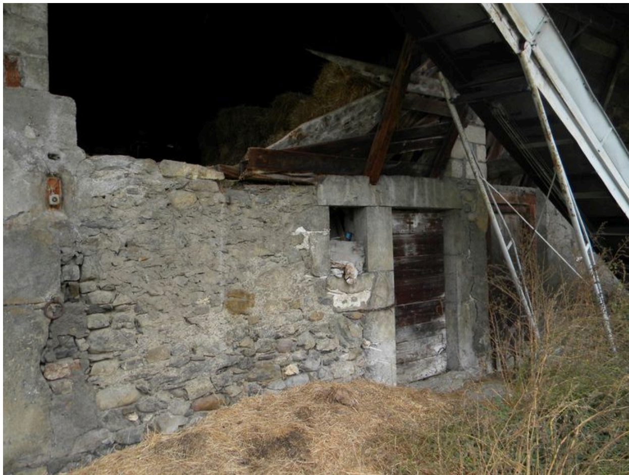
Détail de la façade est.
