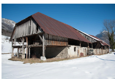
Vue de la partie couverte en pignon sud. Phot. Emmanuel Breteau IVR82_20137301522NUCA
