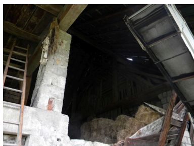
Juxtaposition de charpente et surélévation de toiture. Phot. Jérôme Daviet IVR82_20107304006NUCA
