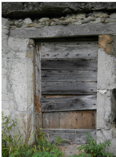
Encadrement de porte avec linteau bois et piedroits de remploi. Phot. Jérôme Daviet IVR82_20107304004NUCA
