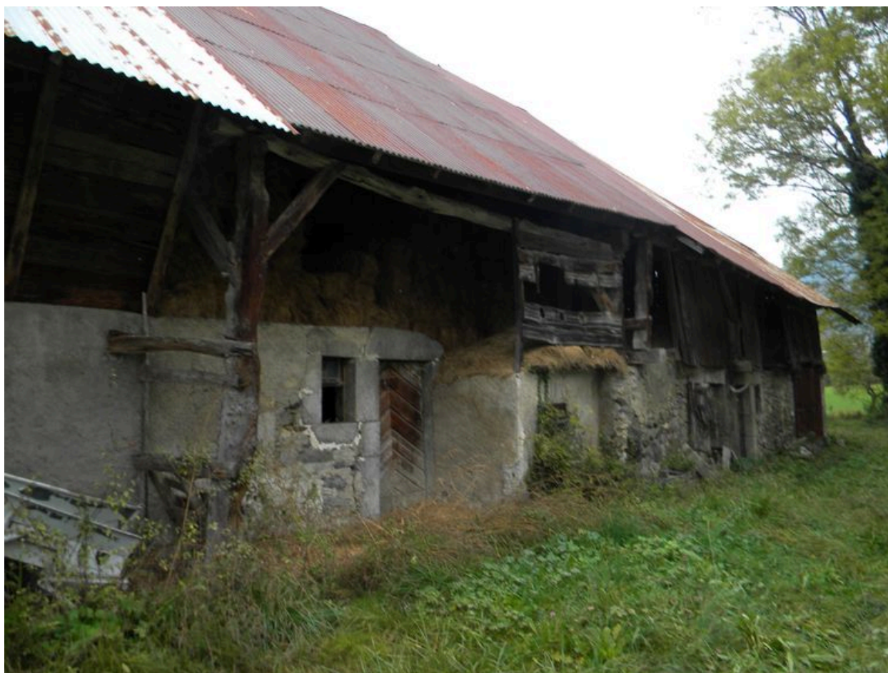
Vue de la façade est.
