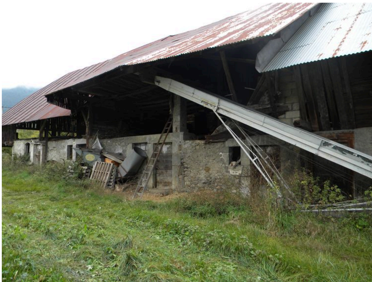
Partie nord de la façade est.
