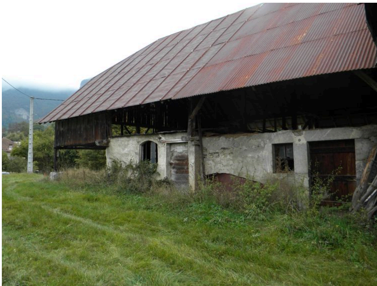
Vue de la façade est depuis le nord.
