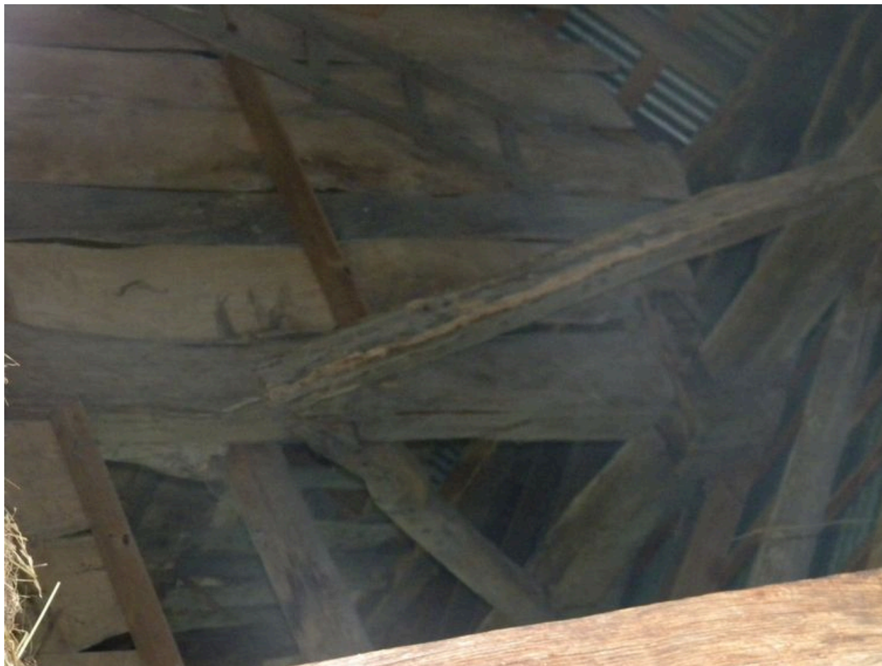
Détail de la charpente.
