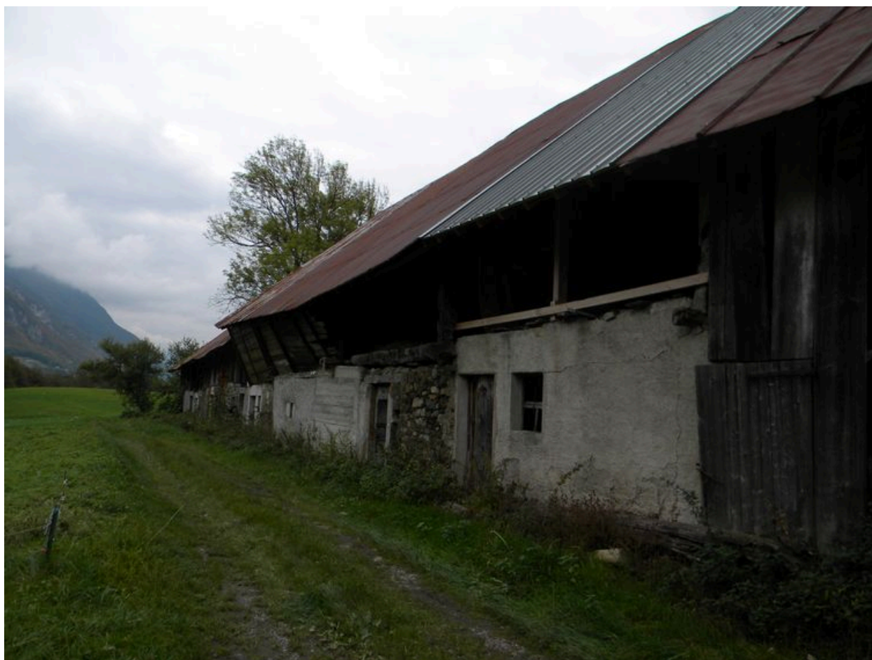
Vue de la façade ouest le long de la route.
