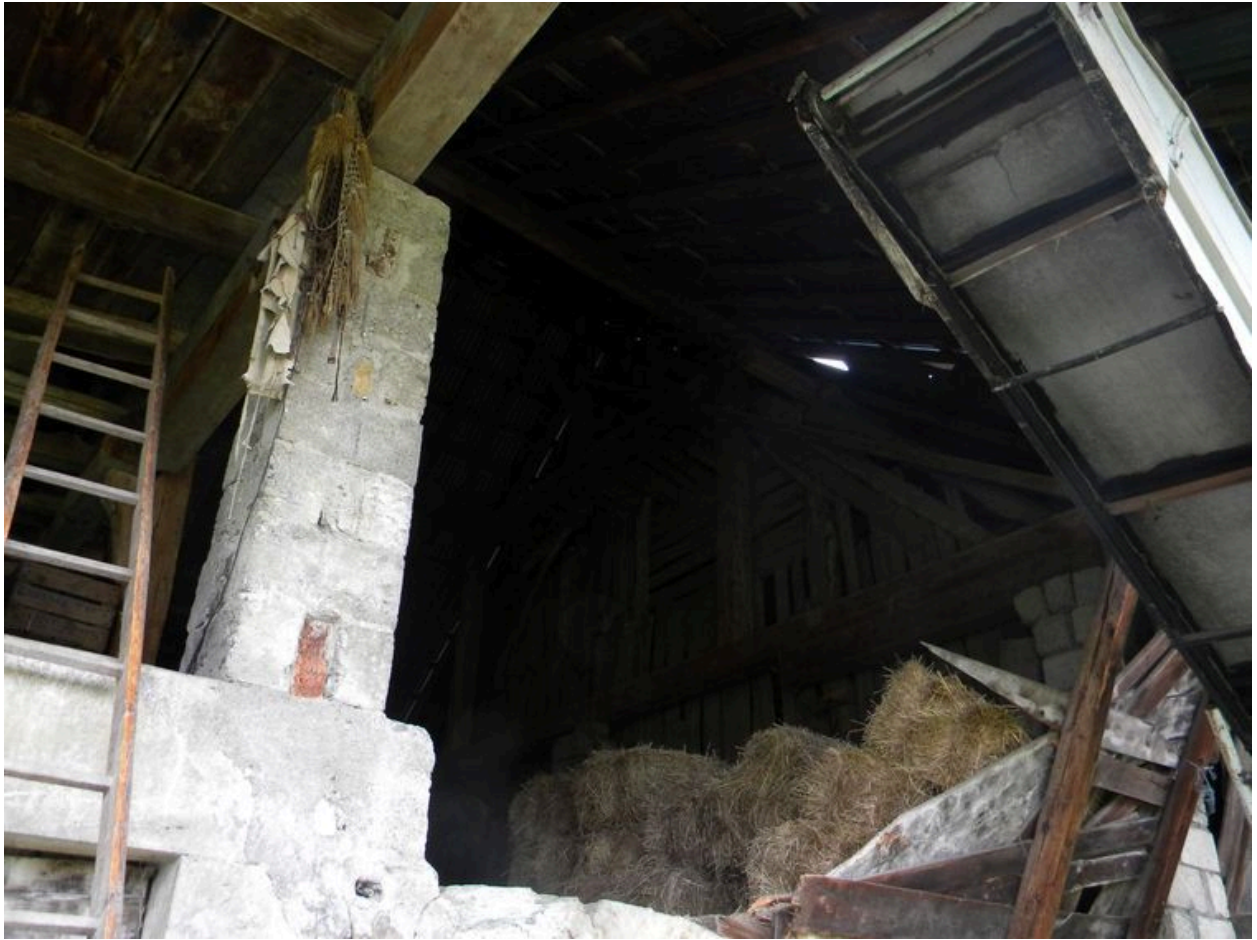
Juxtaposition de charpente et surélévation de toiture.
