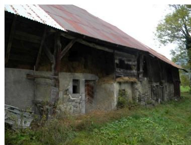
Vue de la façade est. Phot. Jérôme Daviet IVR82_20107304008NUCA
