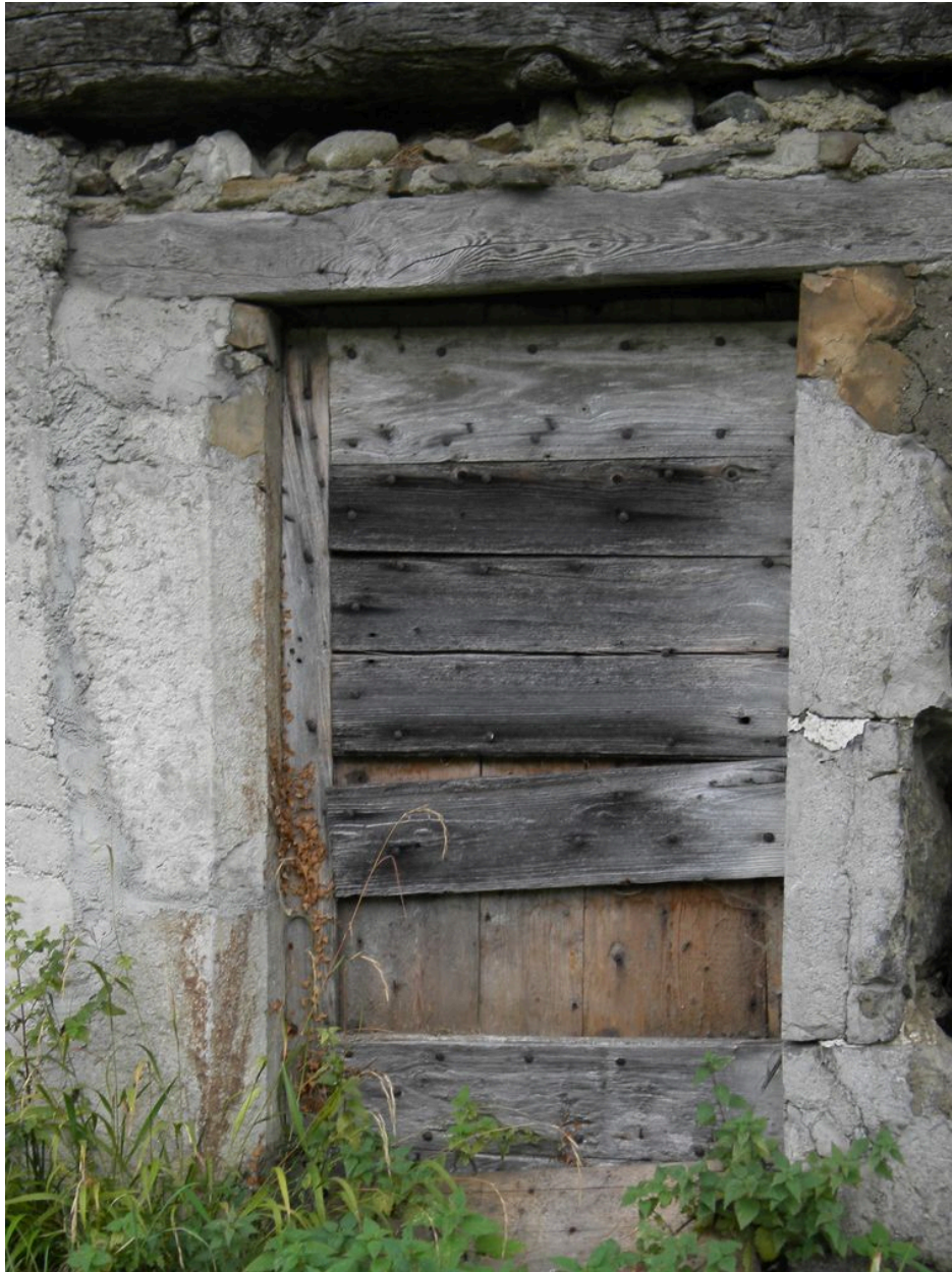
Encadrement de porte avec linteau bois et piedroits de rempli.
