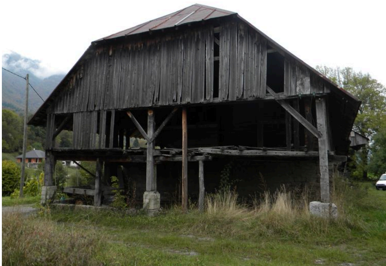
Vue de la partie couverte en façade sud.
