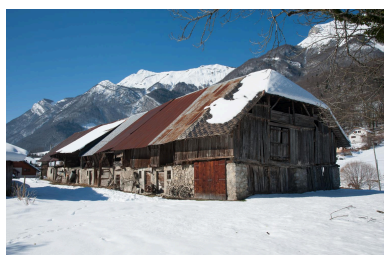
Vue d'ensemble. Phot. Emmanuel Breteau IVR82_20137301523NUCA
