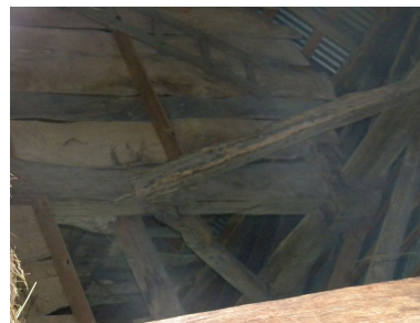
Détail de la charpente. Phot. Jérôme Daviet IVR82_20107304005NUCA
