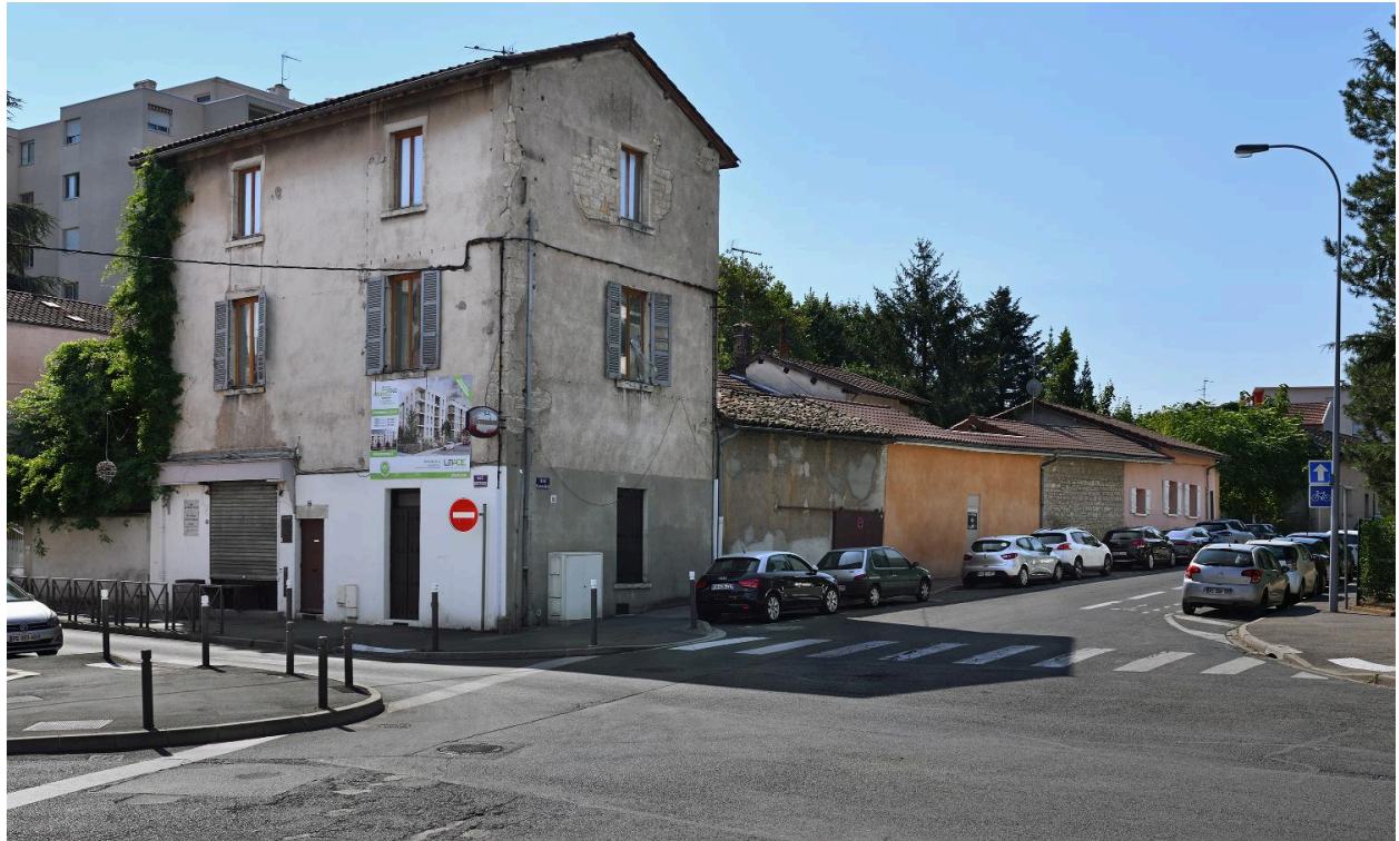
Vue d'ensemble de la corderie avec le bâtiment administratif et logement
