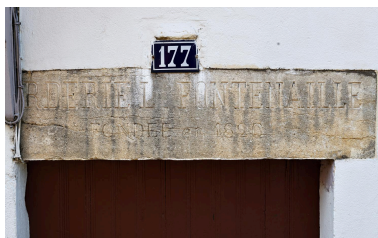
Date et nom portés "Corderie Fontenaille fondée en 1820". Phot. Thierry Leroy IVR84_20226901352NUCA
