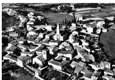
LEZIGNEUX (Loire). 1 - Vue générale. COMBIER IMP. MACON (S.-et-L.) 'CIM' -24- PHOTOGRAPHIE VERITABLE. Reproduction interdite. [Vue générale aérienne du bourg, depuis le sud-est].
