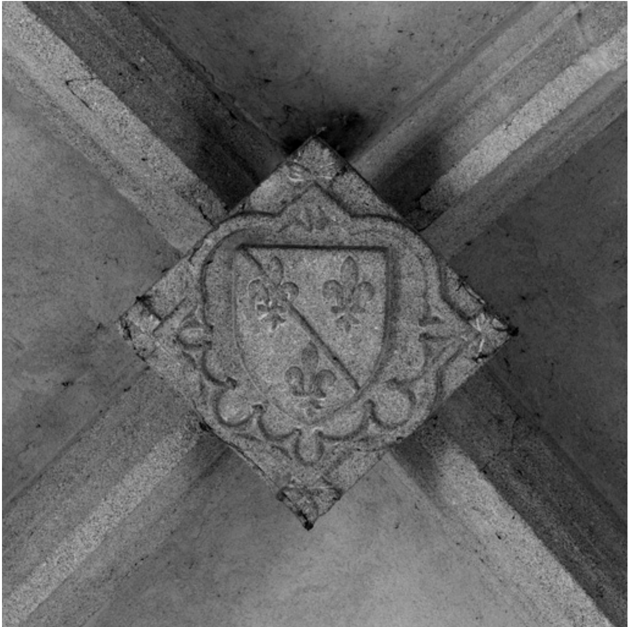
Vue de la clef de voûte de la 1ère travée du collatéral sud (armoiries des Bourbon).
