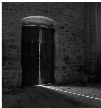
Vue d'ensemble intérieure du portail. Phot. Eric Dessert IVR82_20064200419NUC
