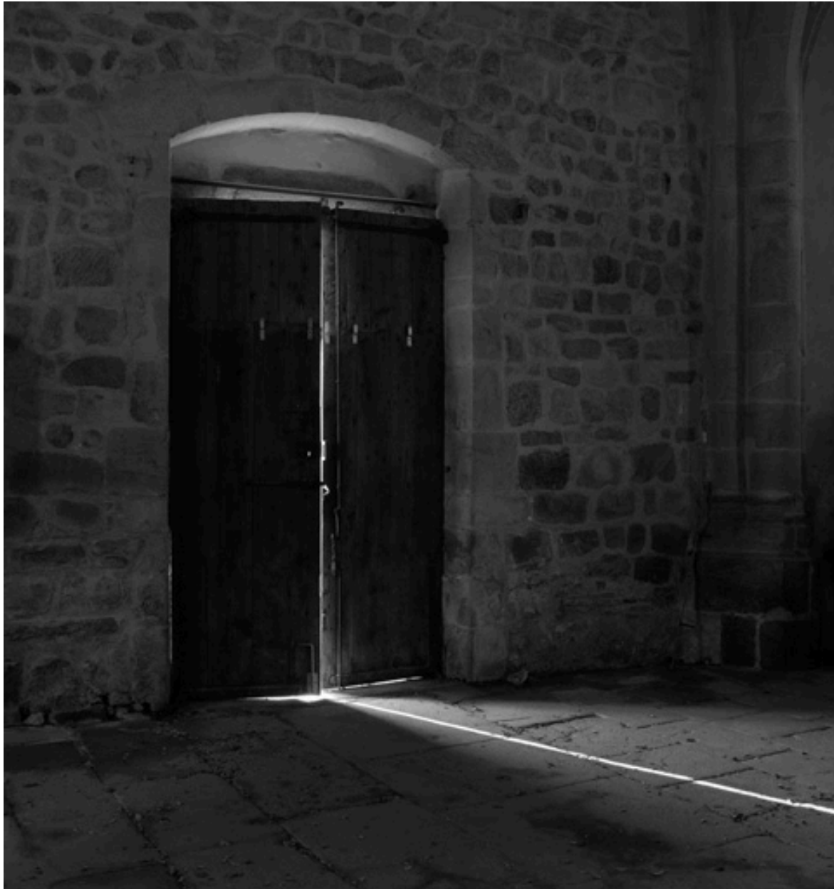
Vue d'ensemble intérieure du portail.
