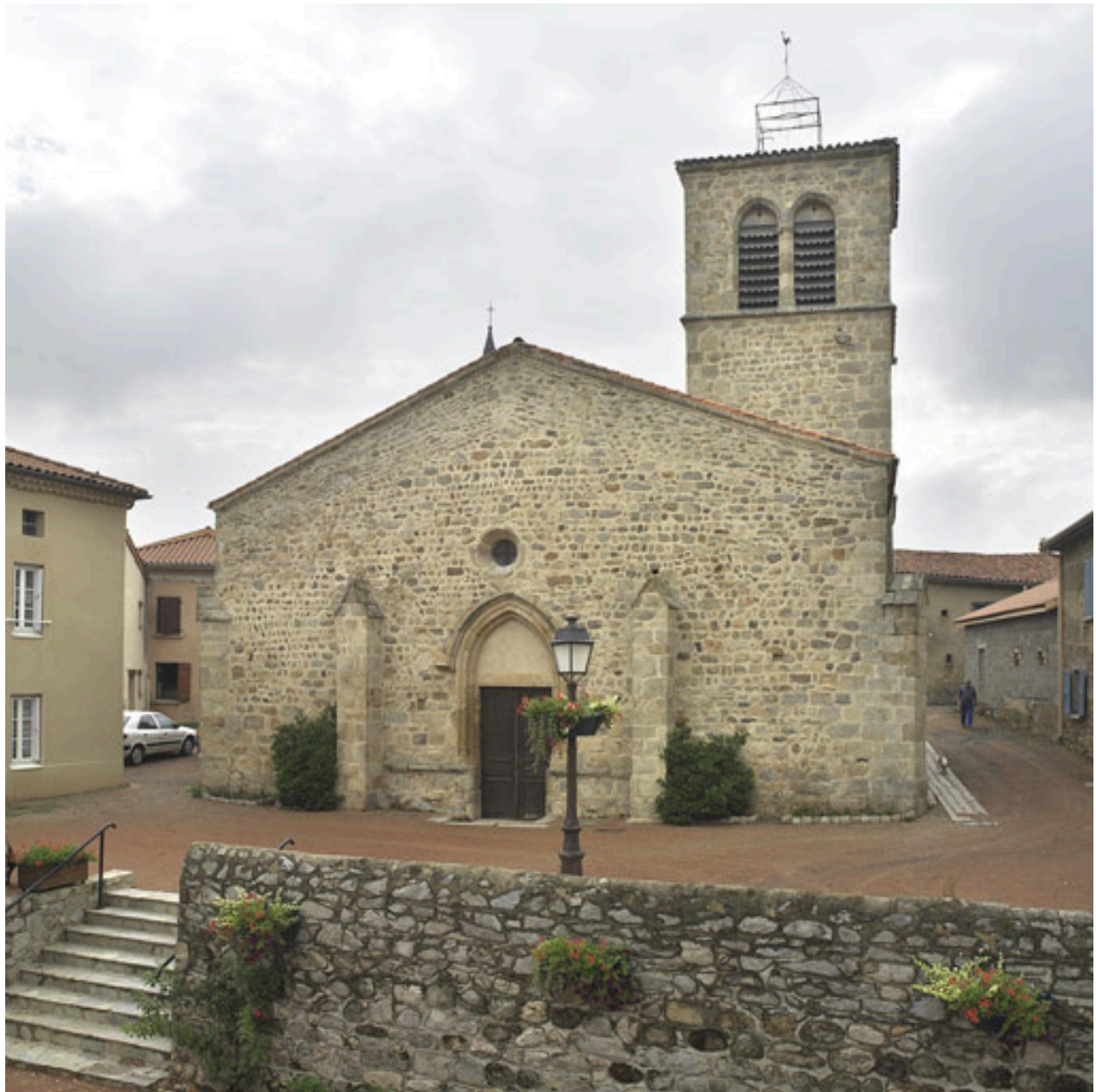
Vue d'ensemble de trois-quarts, depuis le sud-ouest.
