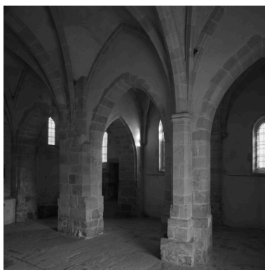
Vue d'ensemble intérieure de trois-quarts, depuis le nord-ouest. Phot. Eric Dessert IVR82_20064200414NUC
