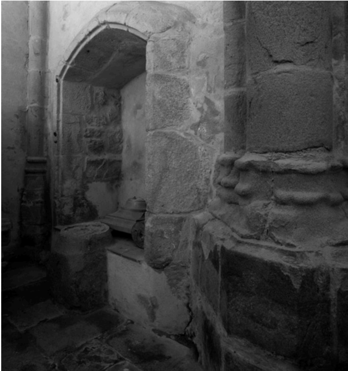
Vue du placard de la première travée du collatéral nord.
