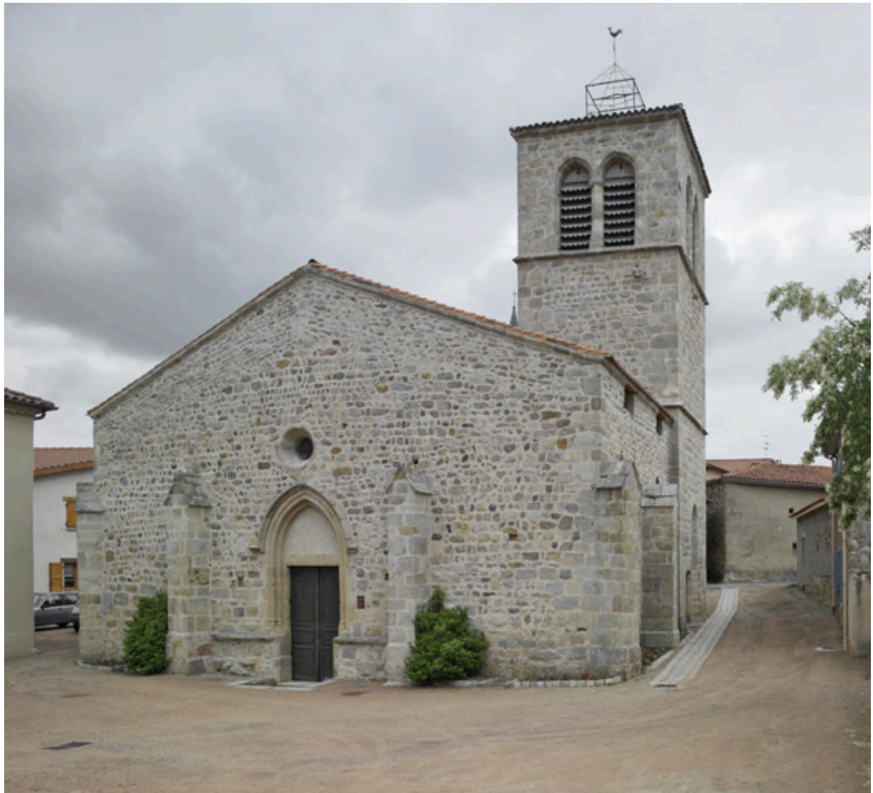
Vue d'ensemble de trois-quarts, depuis le sud-ouest.
