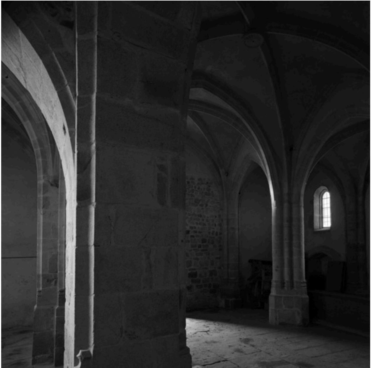
Vue d'ensemble intérieure de trois-quarts, depuis le sud-est.
