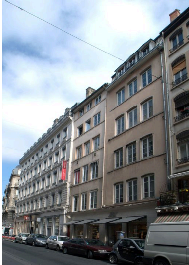
Vue d'ensemble des immeubles 3 et 5 rue Jean de Tournes Phot. Catherine Guégan IVR82_20086902838NUCA
