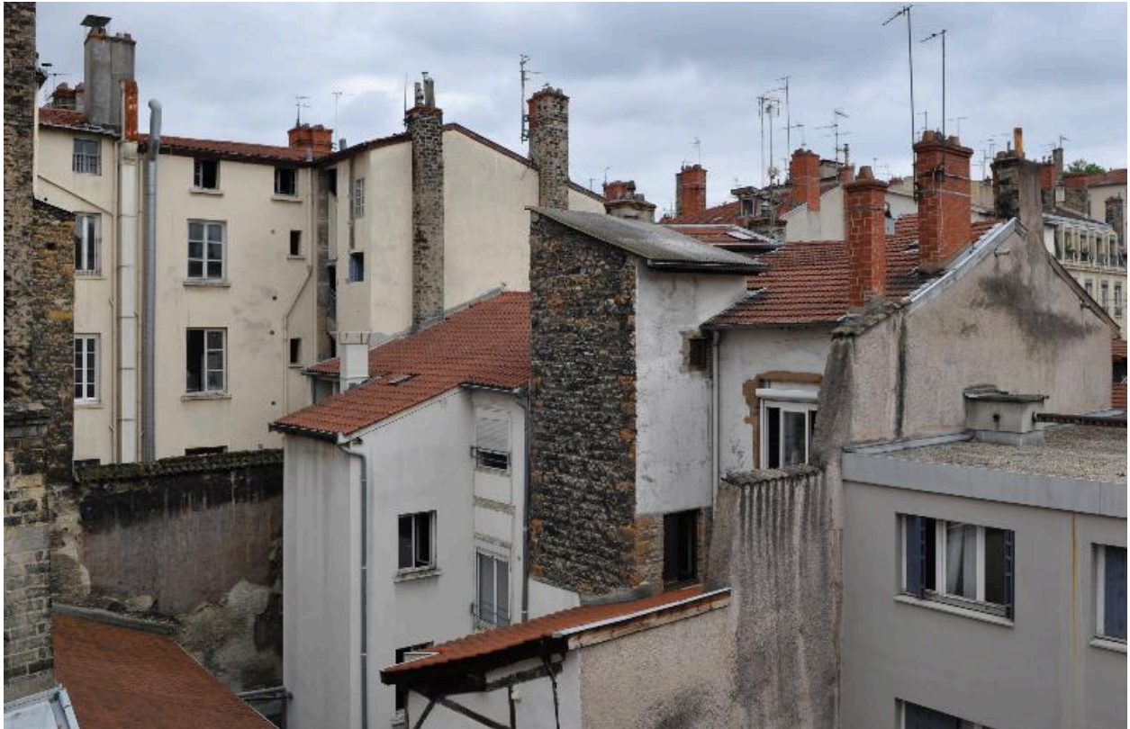
Vue postérieure : tour d'escalier en retour sur cour, élévation en moellons apparents
