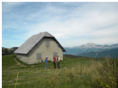
Bâtiment d'habitation : vue de la façade principale en mur pignon. Phot. Thierry Monnet IVR82_20157402258NUCA
