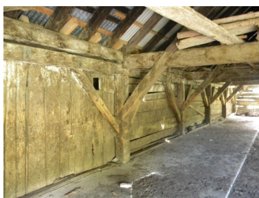
Etable, vue intérieure : mur ouest, charpente et bardage. Phot. Thierry Monnet IVR82_20157402246NUCA
