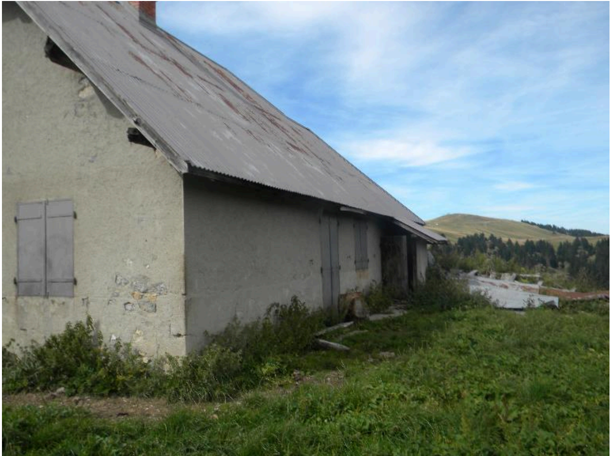
Bâtiment d'habitation : vue de la façade est.
