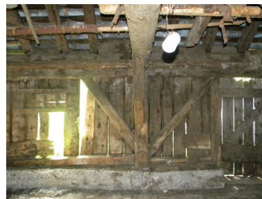
Etable, vue intérieure : ouvertures dans le mur est (jour à volet coulissant, porte). Phot. Thierry Monnet IVR82_20157402256NUCA
