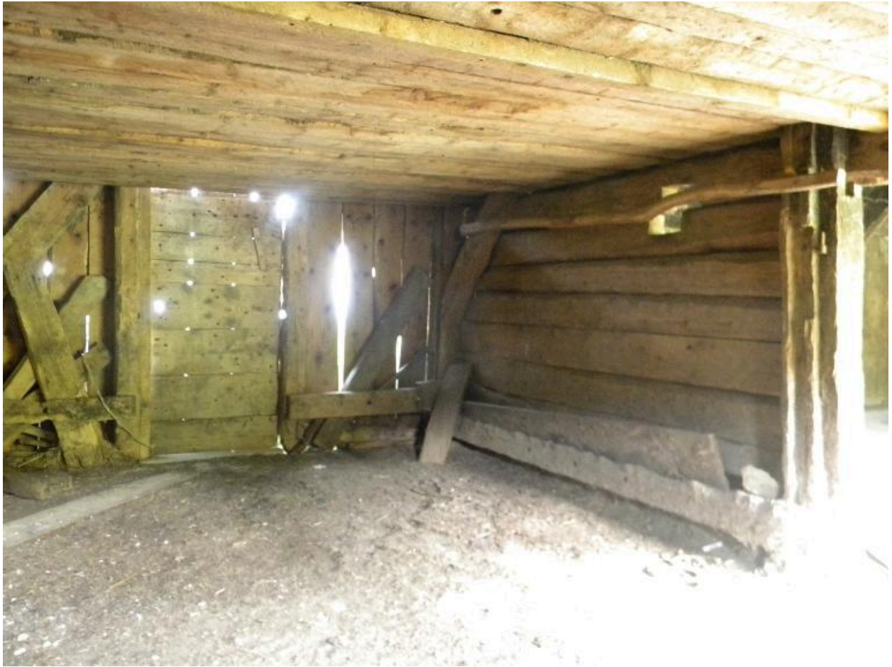
Etable, vue intérieure : porte d'accès.
