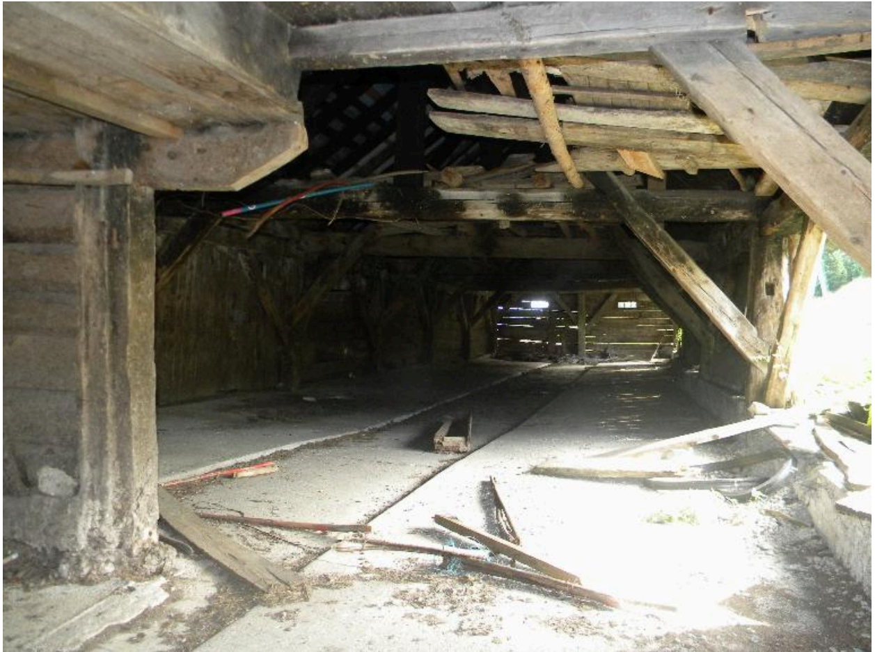
Etable, vue intérieure : partie effondrée du mur est.
