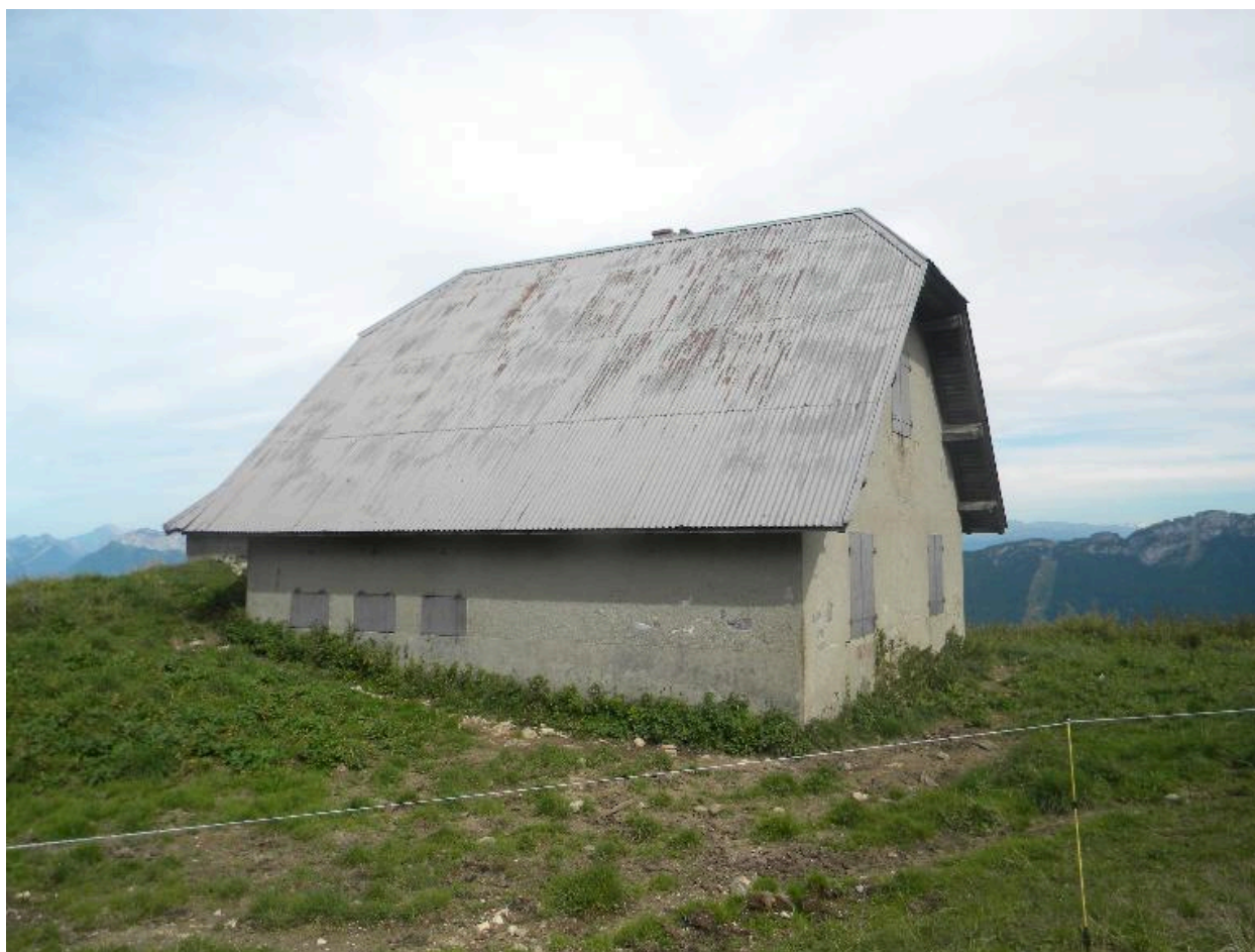
Bâtiment d'habitation : vue de trois-quarts sud-ouest.
