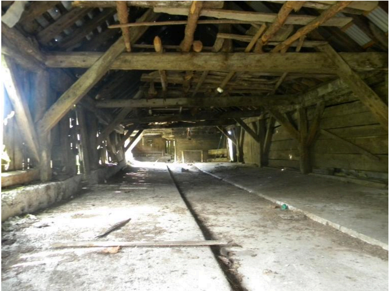
Etable : vue d'ensemble intérieure vers le nord.
