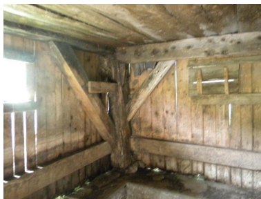
Etable, vue intérieure : système de renfort au niveau d'un angle, jour à volet coulissant. Phot. Thierry Monnet IVR82_20157402252NUCA
