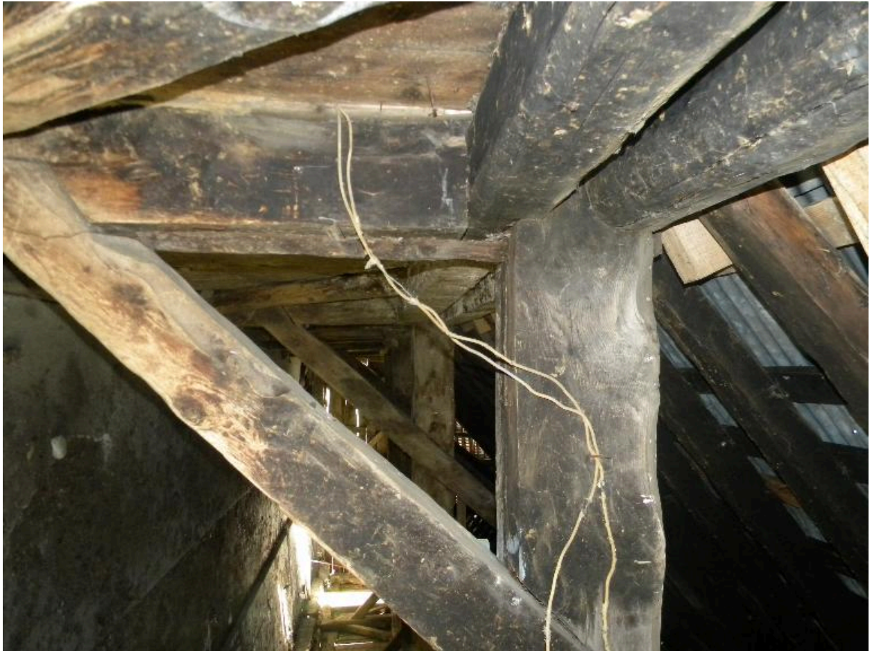
Etable, vue intérieure : détail de charpente.
