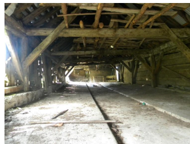
Etable : vue d'ensemble intérieure vers le nord. Phot. Thierry Monnet IVR82_20157402244NUCA
