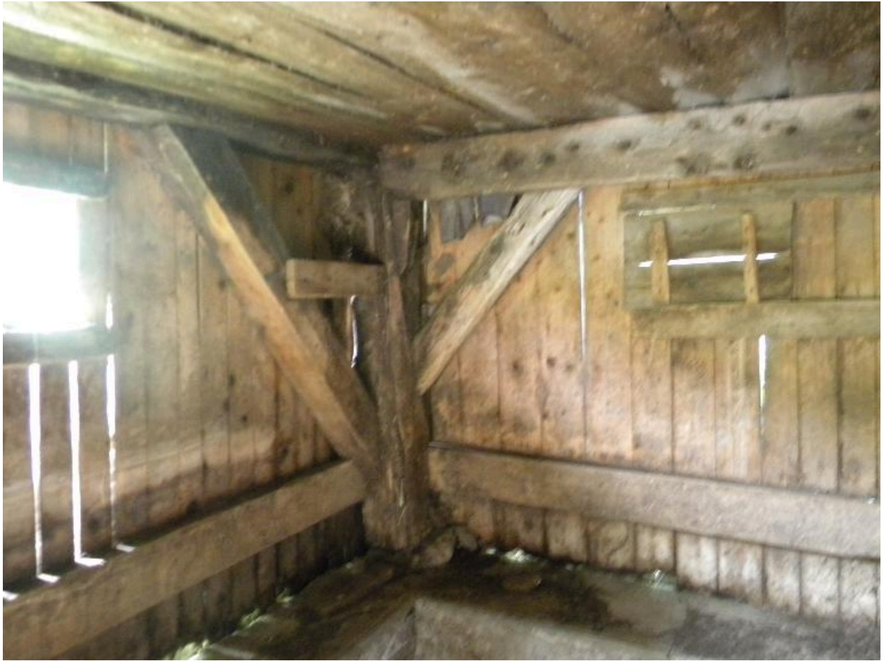
Etable, vue intérieure : système de renfort au niveau d'un angle, jour à volet coulissant.
