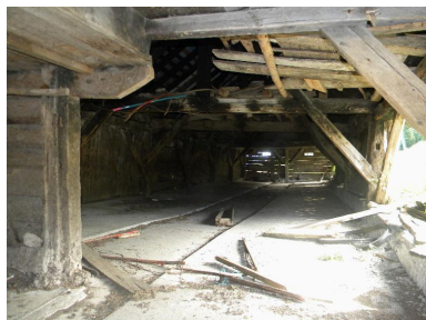
Etable, vue intérieure : partie effondrée du mur est. Phot. Thierry Monnet IVR82_20157402251NUCA
