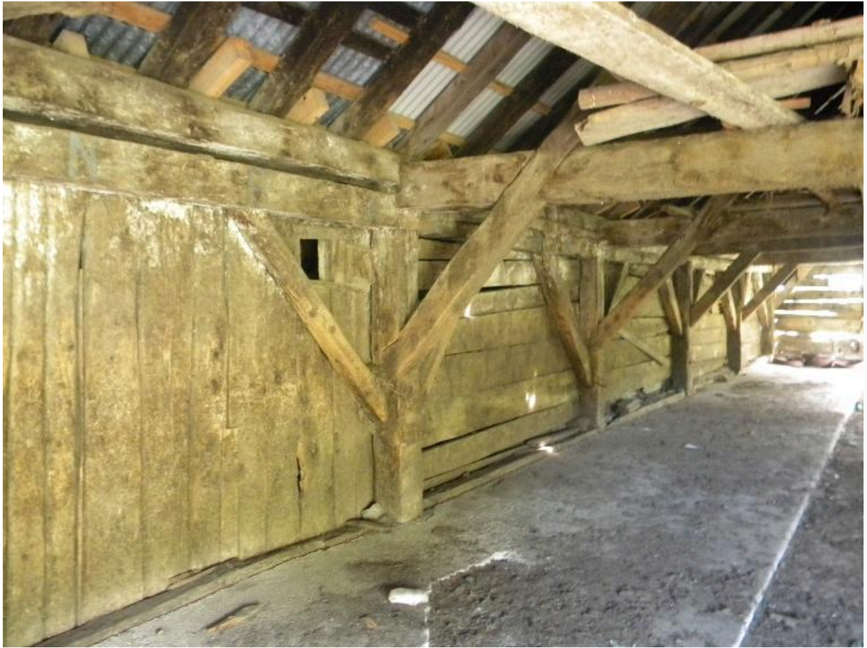
Etable, vue intérieure : mur ouest, charpente et bardage.
