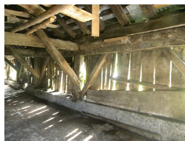
Etable, vue intérieure : mur est, charpente et bardage sur soubassement en béton. Phot. Thierry Monnet IVR82_20157402247NUCA
