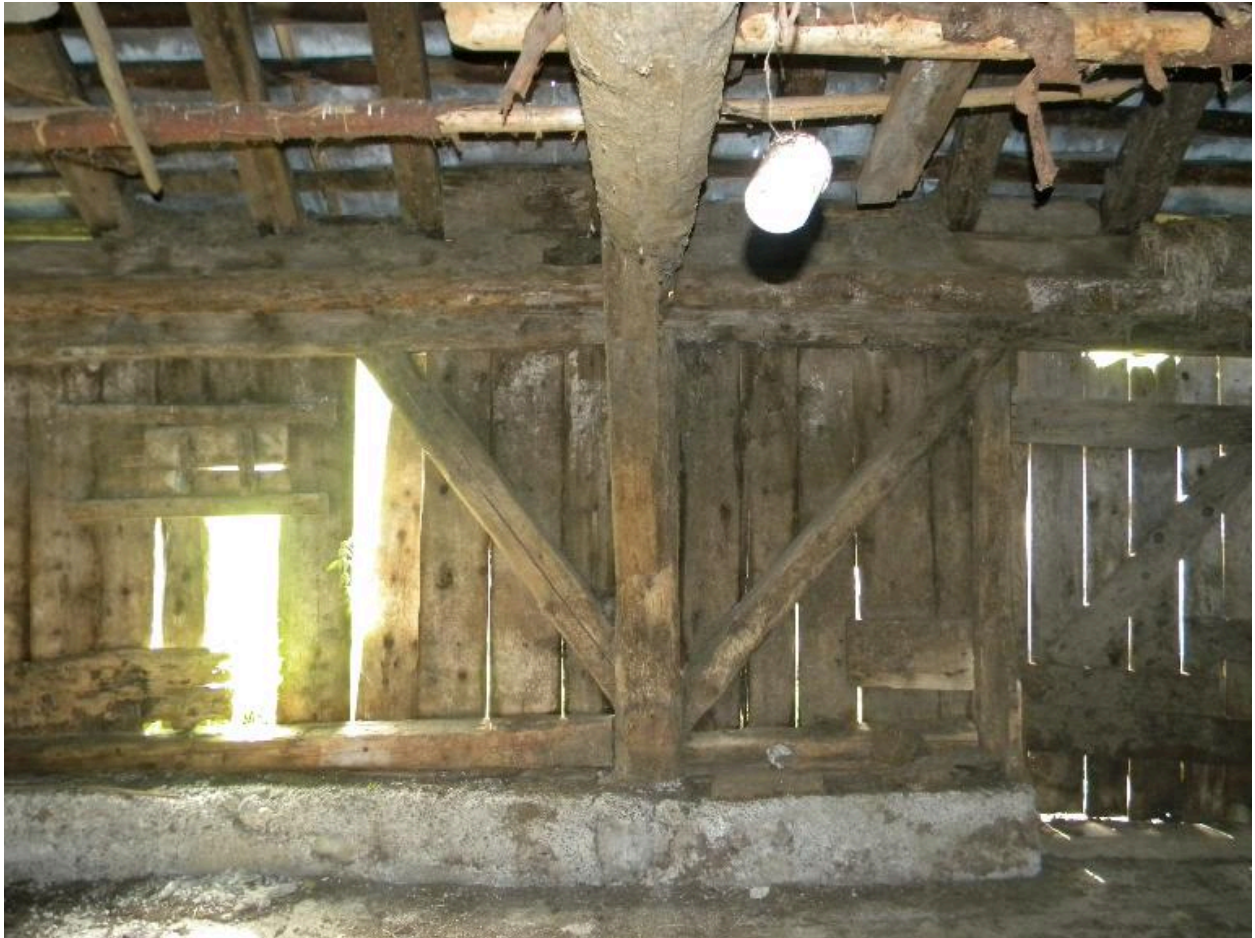
Etable, vue intérieure : ouvertures dans le mur est (jour à volet coulissant, porte).
