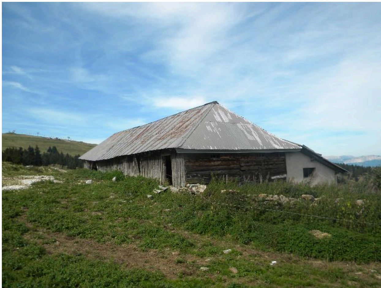
Etable : vue du pignon sud.
