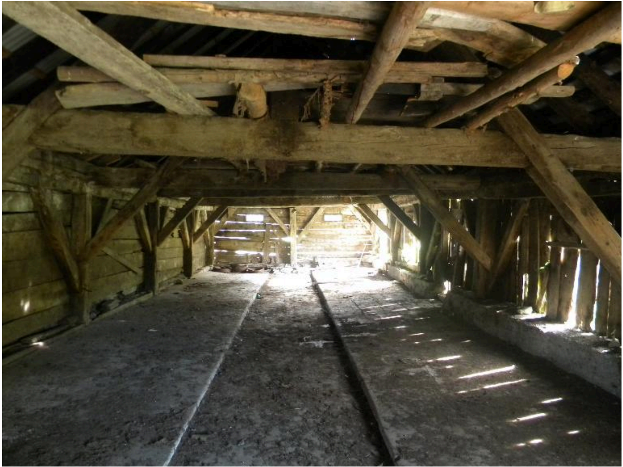
Etable : vue d'ensemble intérieure vers le sud.
