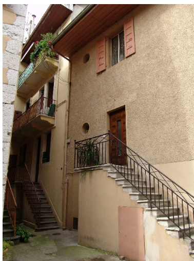
Élévation latérale gauche Phot. François Fouger
