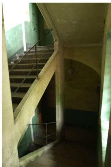
Escalier, vue prise depuis le repos vers le palier du premier étage Phot. François Blanchetière IVR82_20016901548NUCA
