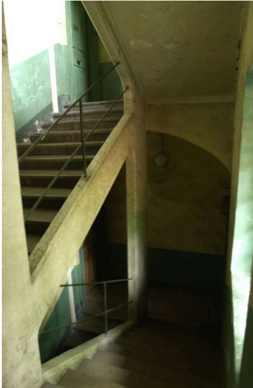
Escalier, vue prise depuis le repos vers le palier du premier étage
