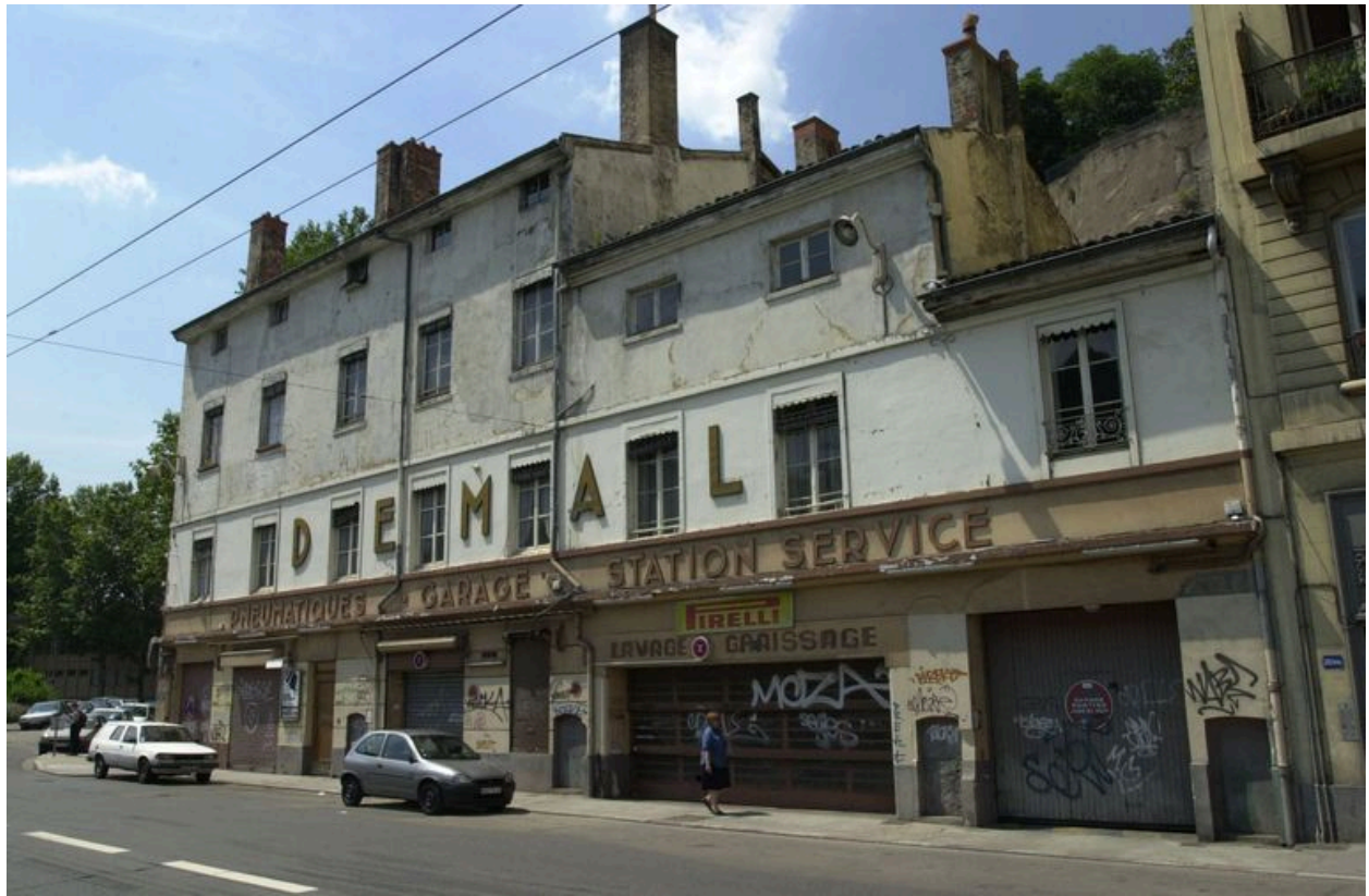
Façade sur le quai, vue depuis l'est
