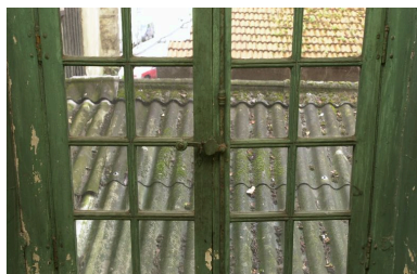
Fenêtre du premier étage, dans la cage d'escalier Phot. François Blanchetière IVR82_20016901551NUCA
