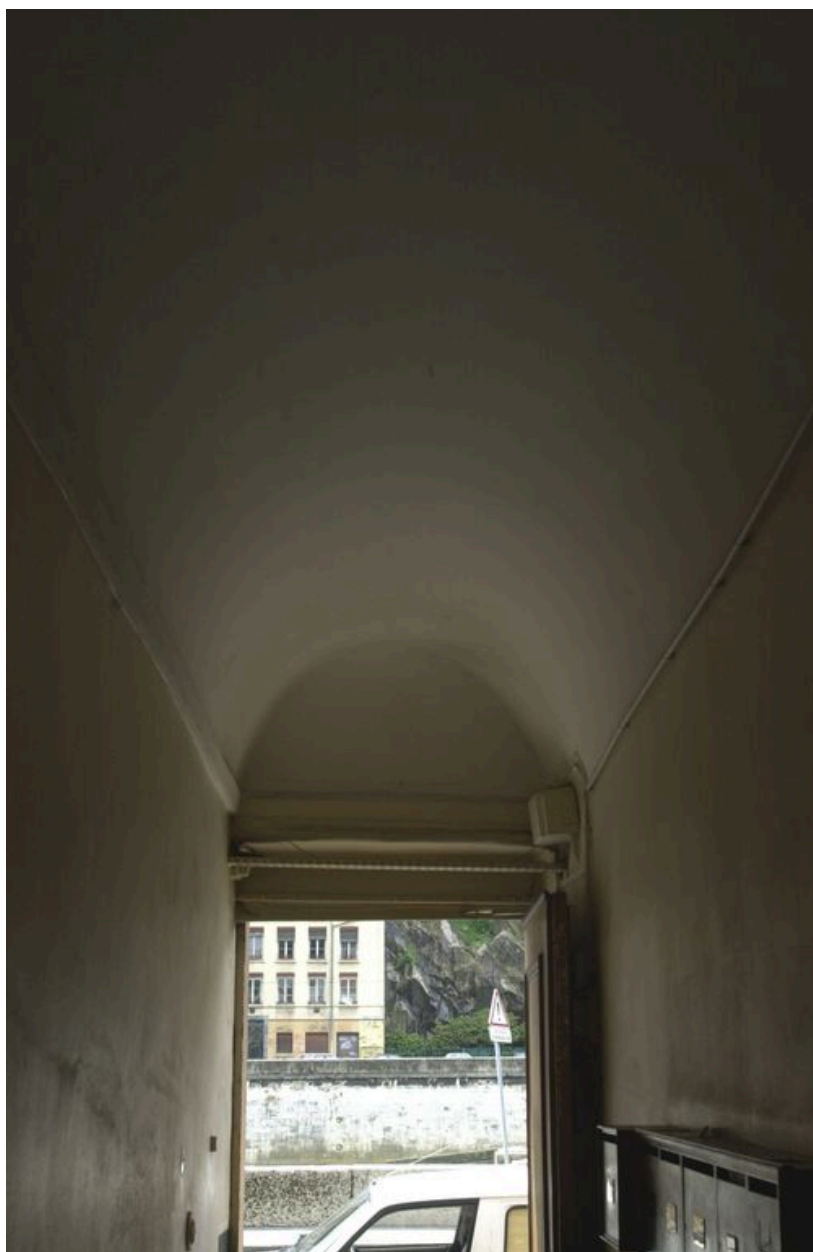
Vue de l'allée voûtée en berceau avec la retombée en arc-de-cloître
