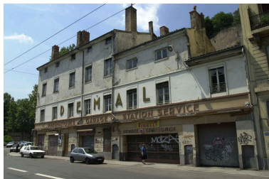
Façade sur le quai, vue depuis l'est Phot. François Blanchetière IVR82_20016901543NUCA
