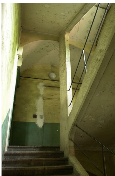
Escalier, vue prise depuis le repos vers le palier du deuxième étage Phot. François Blanchetière IVR82_20016901549NUCA
