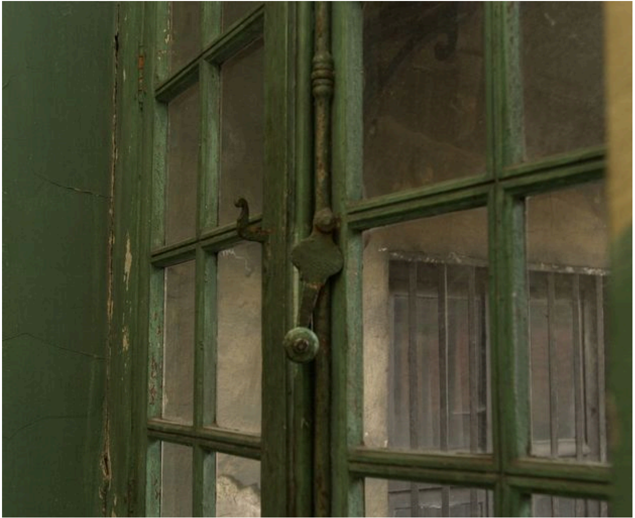
Détail de l'espagnolette de la fenêtre du premier étage
