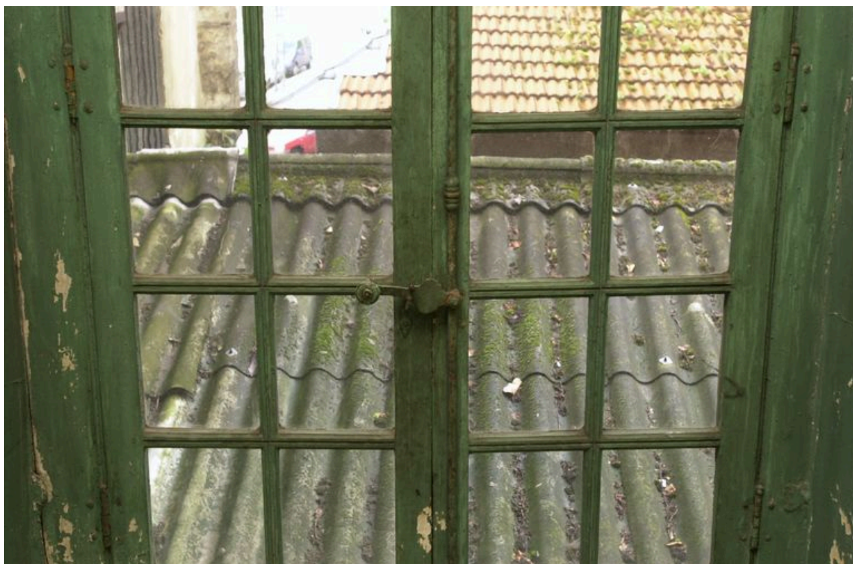
Fenêtre du premier étage, dans la cage d'escalier
