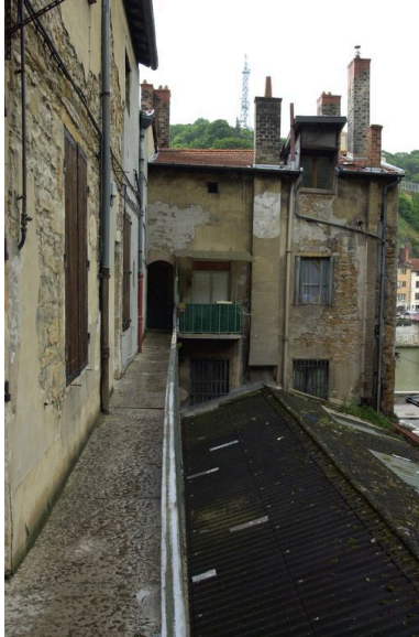
Vue de la coursière du deuxième étage vers le corps sur rue Phot. François Blanchetière IVR82_20016901554NUCA
