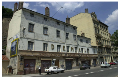
Façade sur le quai, vue depuis l'ouest Phot. François Blanchetière IVR82_20016901542NUCA
