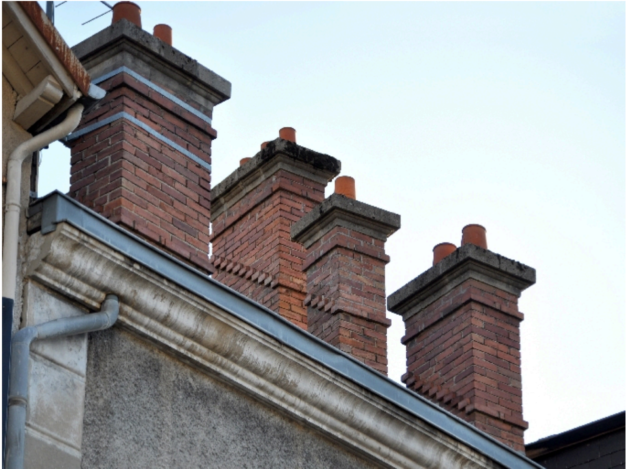
Détail de la corniche
