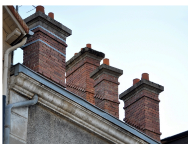
Détail de la corniche Phot. François Fouger IVR82_20097301097NUCA
