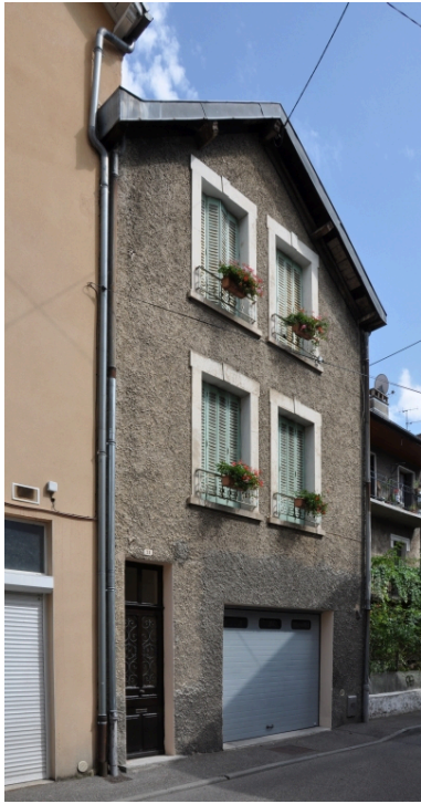
Façade du corps de dépendance sud Phot. François Fouger IVR82_20117300612NUCA
