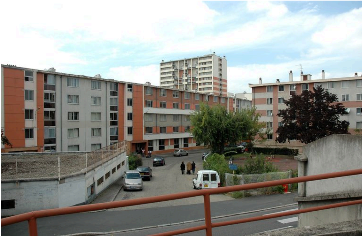
Vue du bâtiment D2, n°62-64 rue du Professeur-Ranvier
