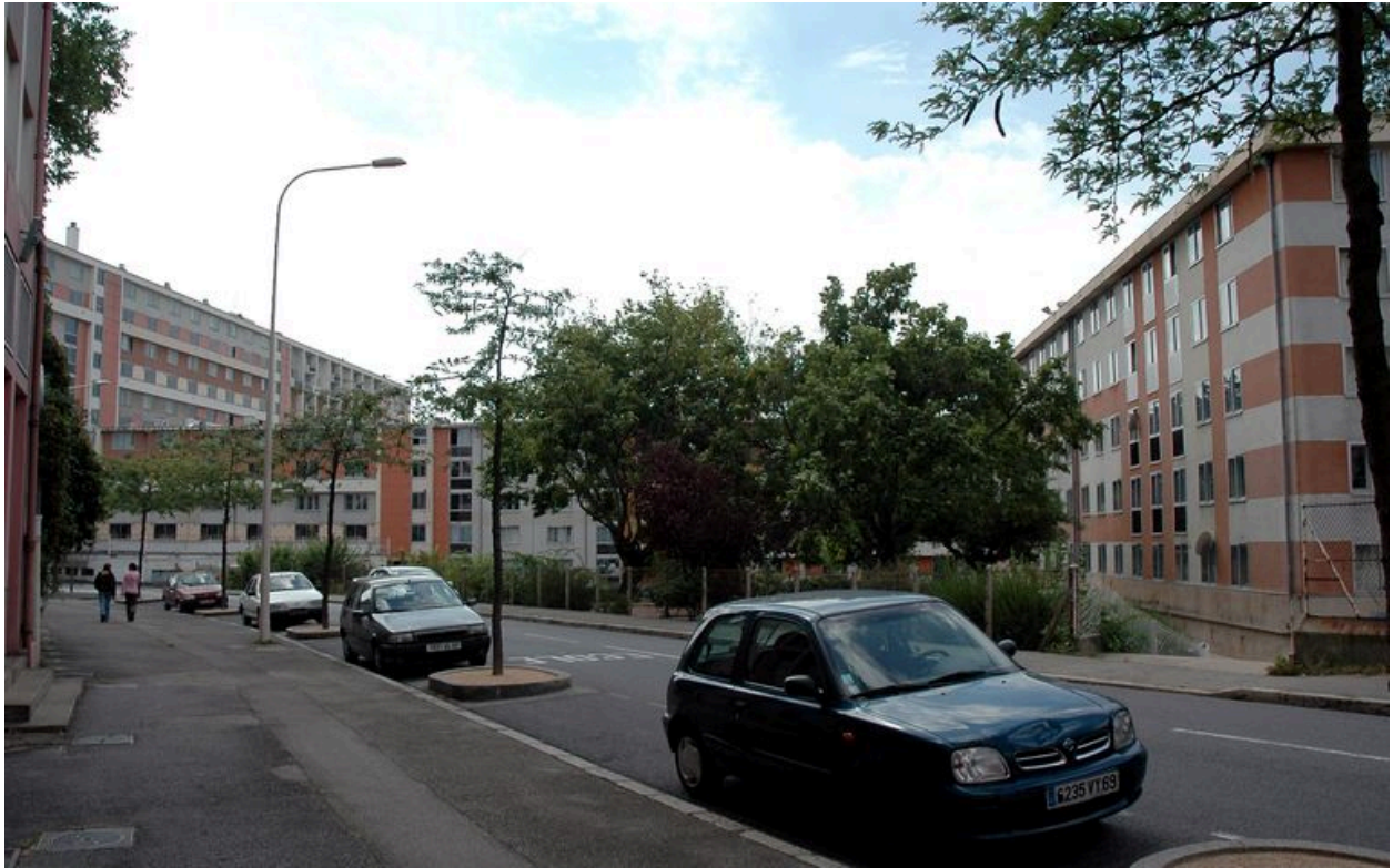
Vue générale depuis l'est
