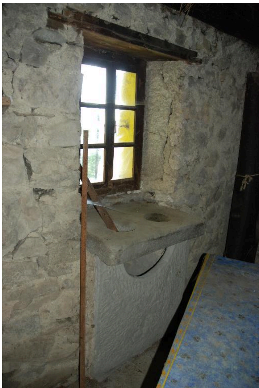
Vue d'ensemble de la fenêtre de la cuisine et du potager.
