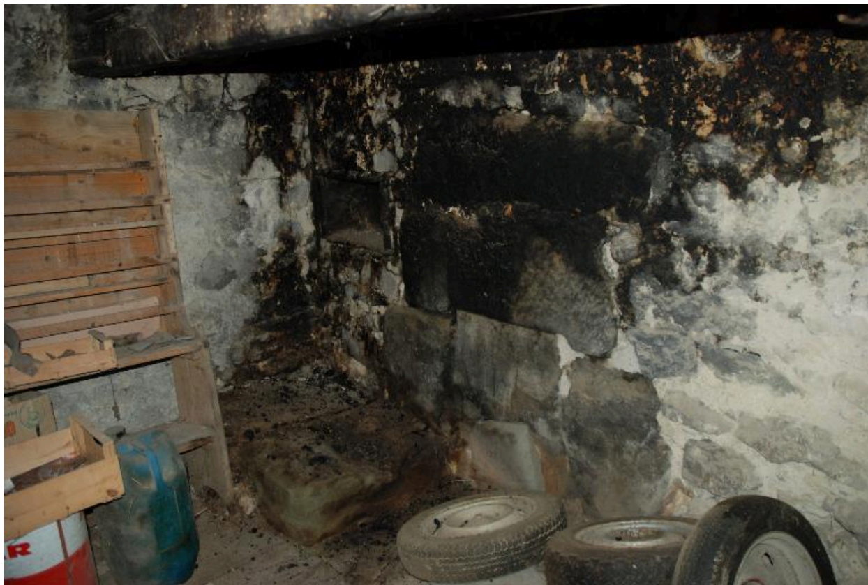
Vue du foyer de la cheminée.
