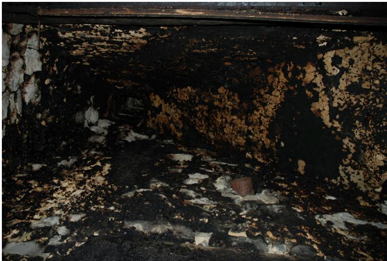
Vue intérieure du conduit de la cheminée.
