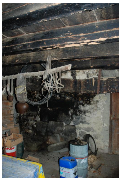
Vue d'ensemble de la cheminée adossée au mur de séparation entre la cuisine et la chambre. Phot. Thierry Monnet IVR82_20157302560NUCA
