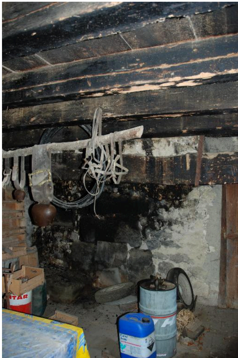
Vue d'ensemble de la cheminée adossée au mur de séparation entre la cuisine et la chambre.
