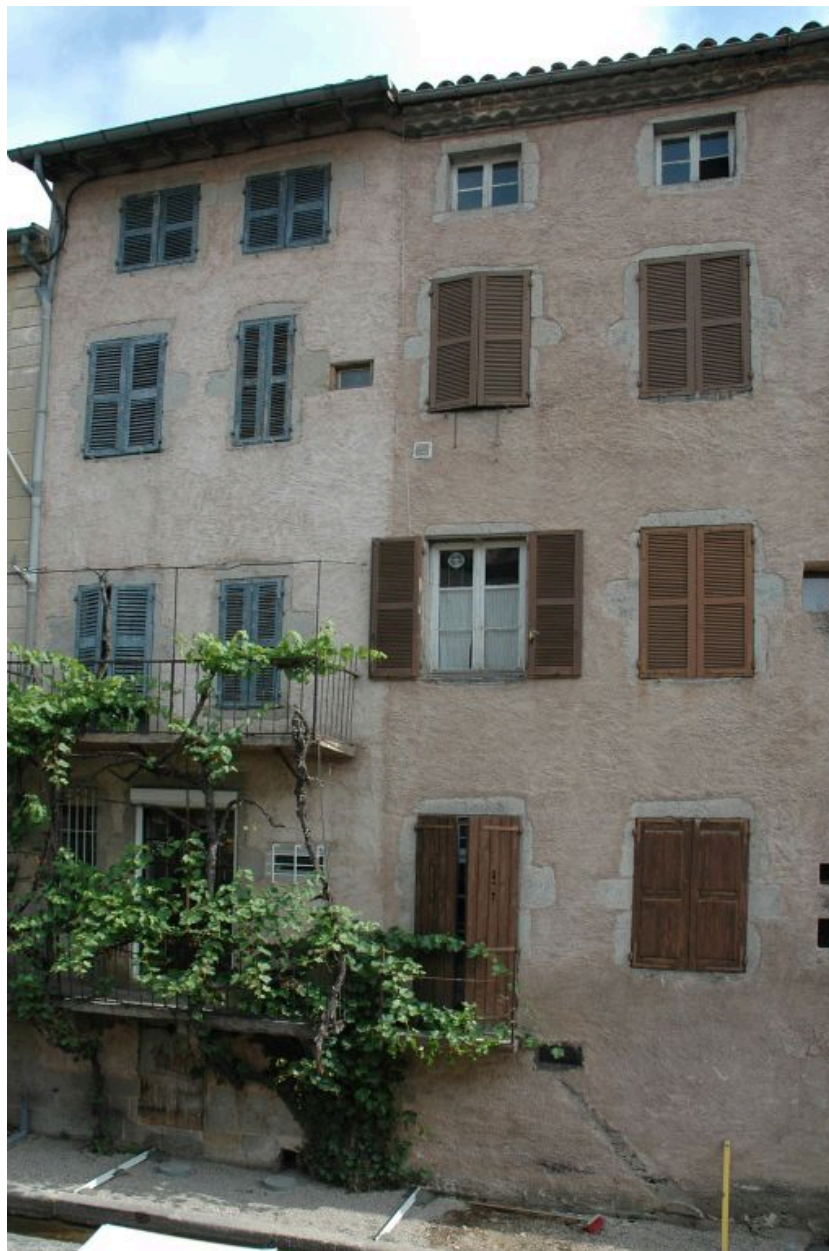
Elévation postérieure, du côté de la rivière.
