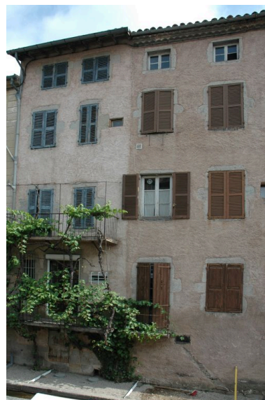
Élévation postérieure, du côté de la rivière. Phot. Simone Hartmann-Nussbaum IVR82_20124201252NUCA
