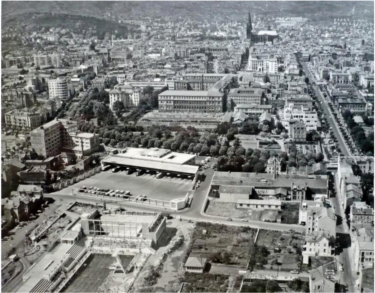
Hôtel-Dieu de Clermont-Ferrand. L'enclos et les bâtiments de l'hôtel-Dieu vus du sud, photographie aérienne, vers 1961.
