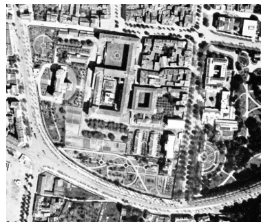
Hôtel-Dieu de Clermont-Ferrand. L'enclos et les bâtiments de l'hôtel-Dieu, photographie aérienne prise à la verticale, vers 1938. IVR84_20166300334NUC4A
