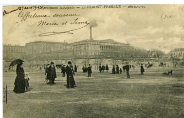
Hôtel-Dieu de Clermont-Ferrand. L'édifice de l'hôtel-Dieu vu du sud-ouest (place Gambetta), vers 1900, carte postale (collection privée). A droite, une partie de la façade ouest de la maternité est visible. IVR84_20166300329NUC4A
