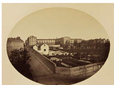
Hôtel-Dieu de Clermont-Ferrand. L'édifice de l'hôtel-Dieu, vu du nord-ouest, vers 1875 (photographie Léopold). Phot. Leopold IVR84_20166300325NUC4A
