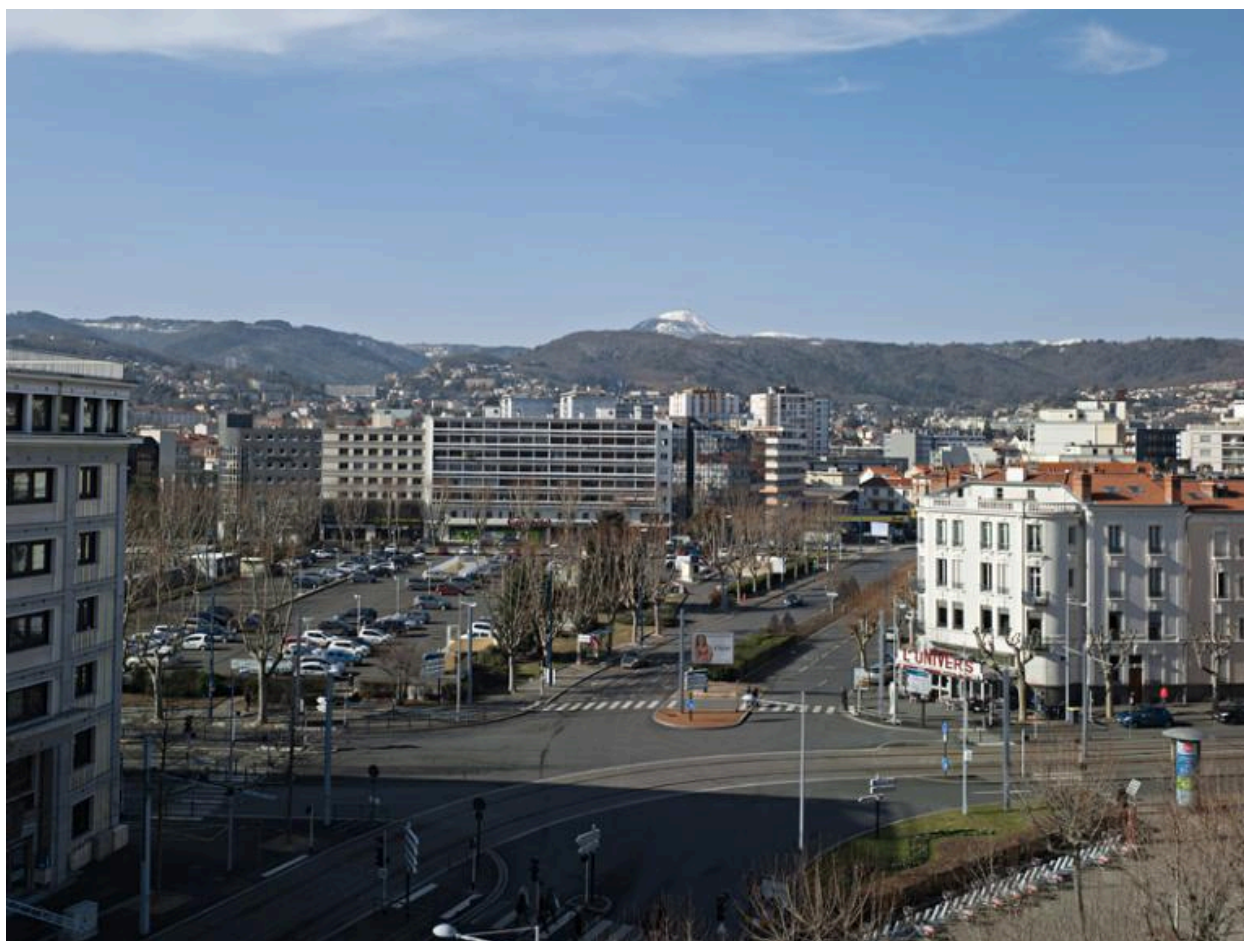
Hôtel-Dieu de Clermont-Ferrand. La ville autour de l'enclos (abord sud-ouest, place des Salins).
