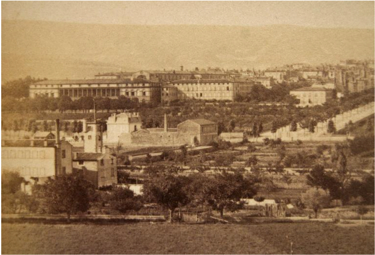
Hôtel-Dieu de Clermont-Ferrand. L'édifice de l'hôtel-Dieu, le Refuge et la maison de santé vus du sud-est, avec l'avenue Vercingétorix, vers 1885, photographie N. D. (détail recadré).
