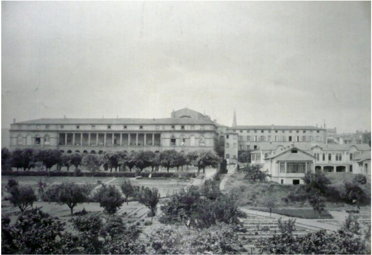
Hôtel-Dieu de Clermont-Ferrand. L'édifice de l'hôtel-Dieu, le Refuge et l'hôpital pour enfants vus du sud, vers 1930.
