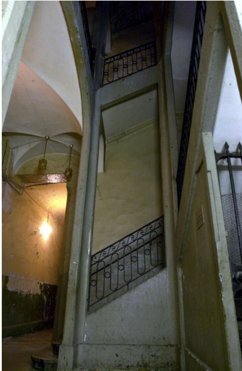
Escalier, vide central au niveau du rez-de-chaussée
