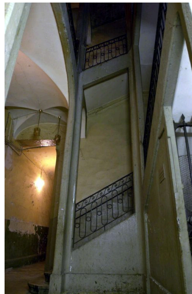
Escalier, vide central au niveau du rez-de-chaussée Phot. François Blanchetière IVR82_20016901494NUCA
