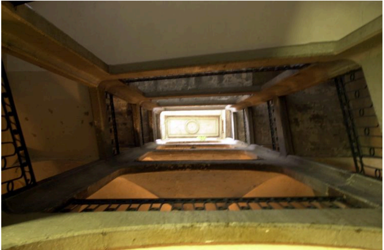
Vide de l'escalier vu depuis le rez-de-chaussée
