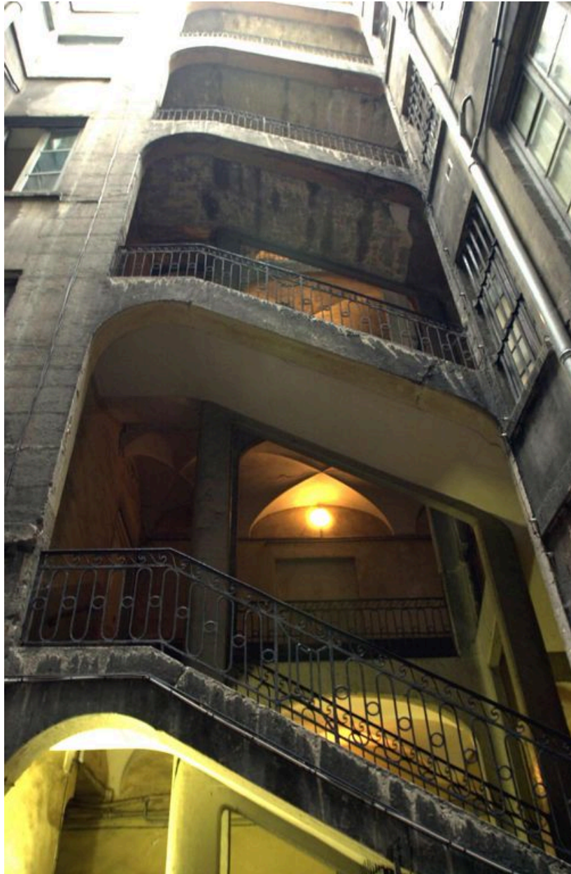
Escalier vu depuis la cour, partie supérieure
