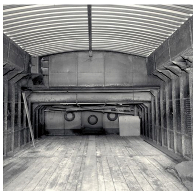
Vue d'ensemble de la cale Phot. Eric Dessert IVR82_20026903698X
