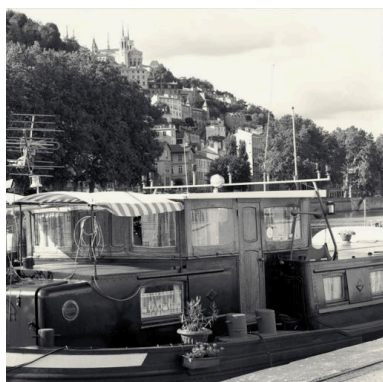
Vue d'ensemble de la cabine Phot. Eric Dessert IVR82_20026903691X
