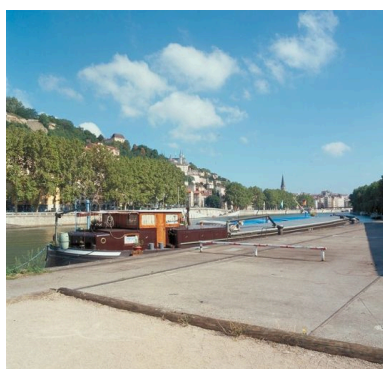
Vue générale Phot. Eric Dessert IVR82_20026903644XA
