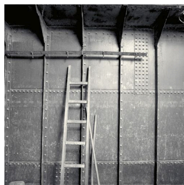
Détail de l'assemblage des parois de la cale Phot. Eric Dessert IVR82_20026903700X
