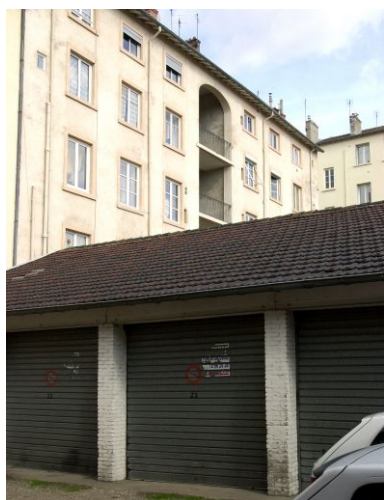
Vue des garages construits au nord de la cour Phot. Maryannick Chalabi IVR82_20016902101NUCA
