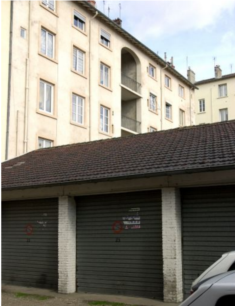
Vue des garages construits au nord de la cour
