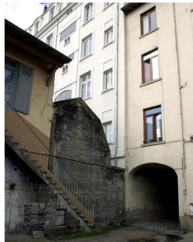
Elévation postérieure Phot. Maryannick Chalabi IVR82_20016902108NUCA
