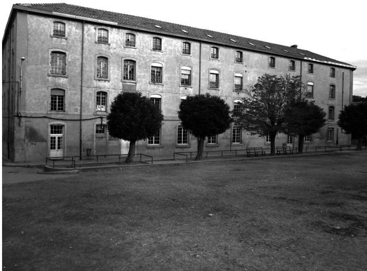
Vue générale de l'élévation extérieure sud du bâtiment est, en 1991
