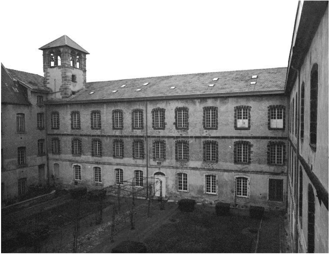
Vue générale de l'élévation est sur cour du bâtiment est, en 1991
