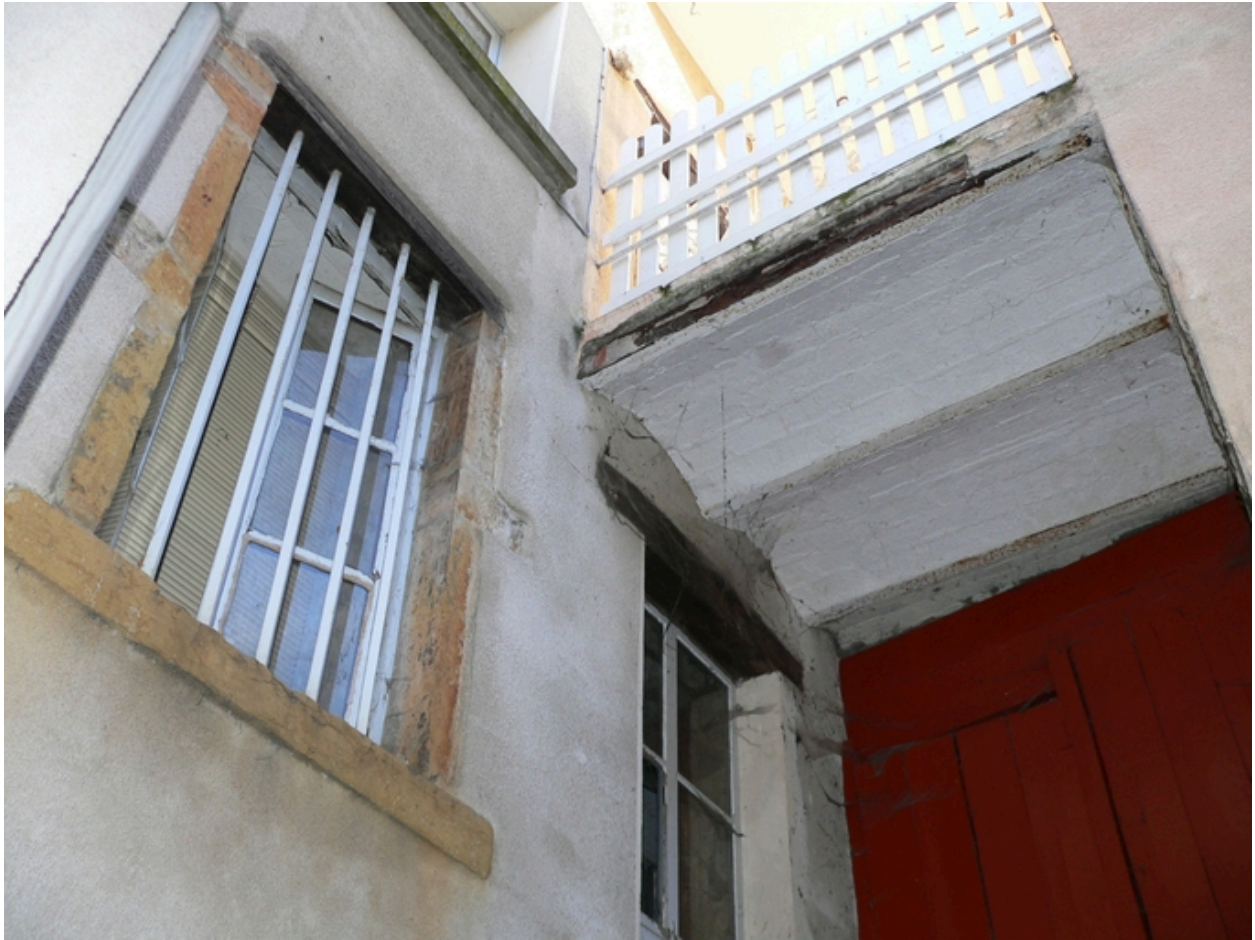
Façade latérale droite
