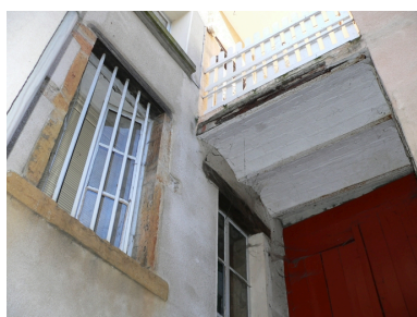
Façade latérale droite Phot. Isabelle Dupuis IVR82_20093800313NUCA
