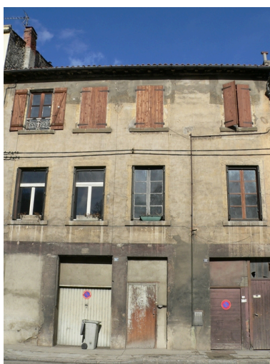
Façade principale Phot. Isabelle Dupuis IVR82_20093800314NUCA
