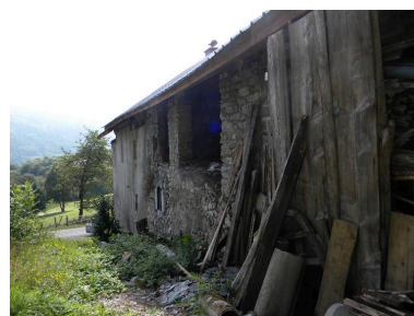
Vue de la façade arrière Phot. Jérôme Daviet IVR82_20137401899NUCA
