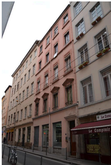
Vue d'ensemble façade ouest Phot. Noémie Caillat IVR82_20156900095NUCA
