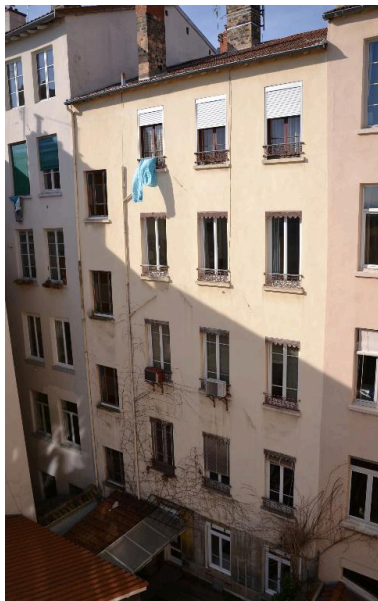
Vue d'ensemble façade est Phot. Noémie Caillat IVR82_20156900259NUCA
